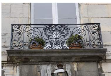
Détail du balcon en ferronnerie sur la façade sur cour du logis principal.
