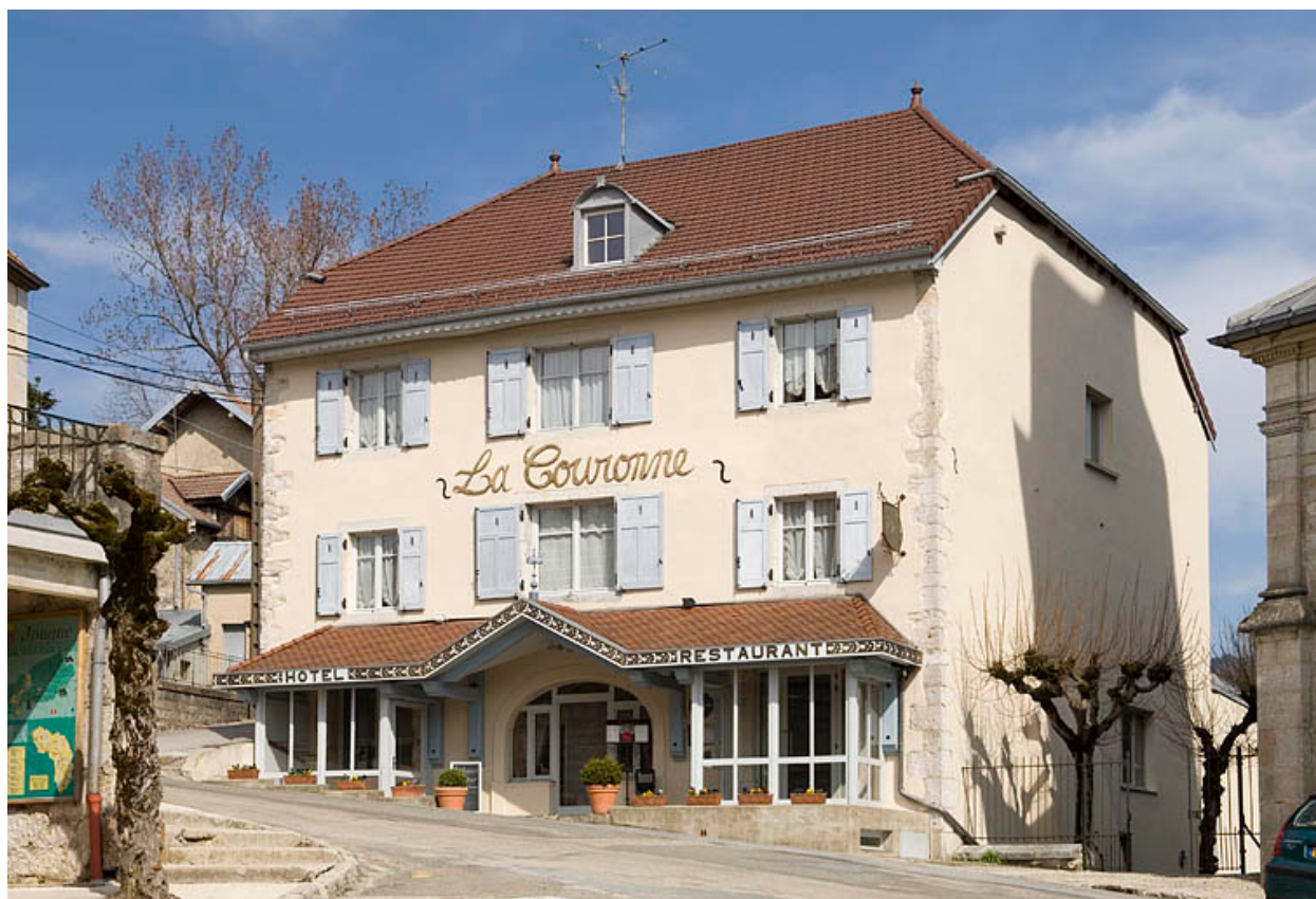
Façade antérieure et façade latérale droite.
