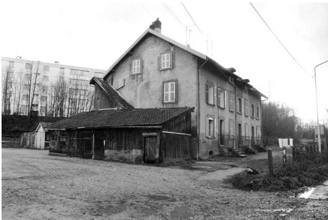
Façades antérieure et latérale gauche.
