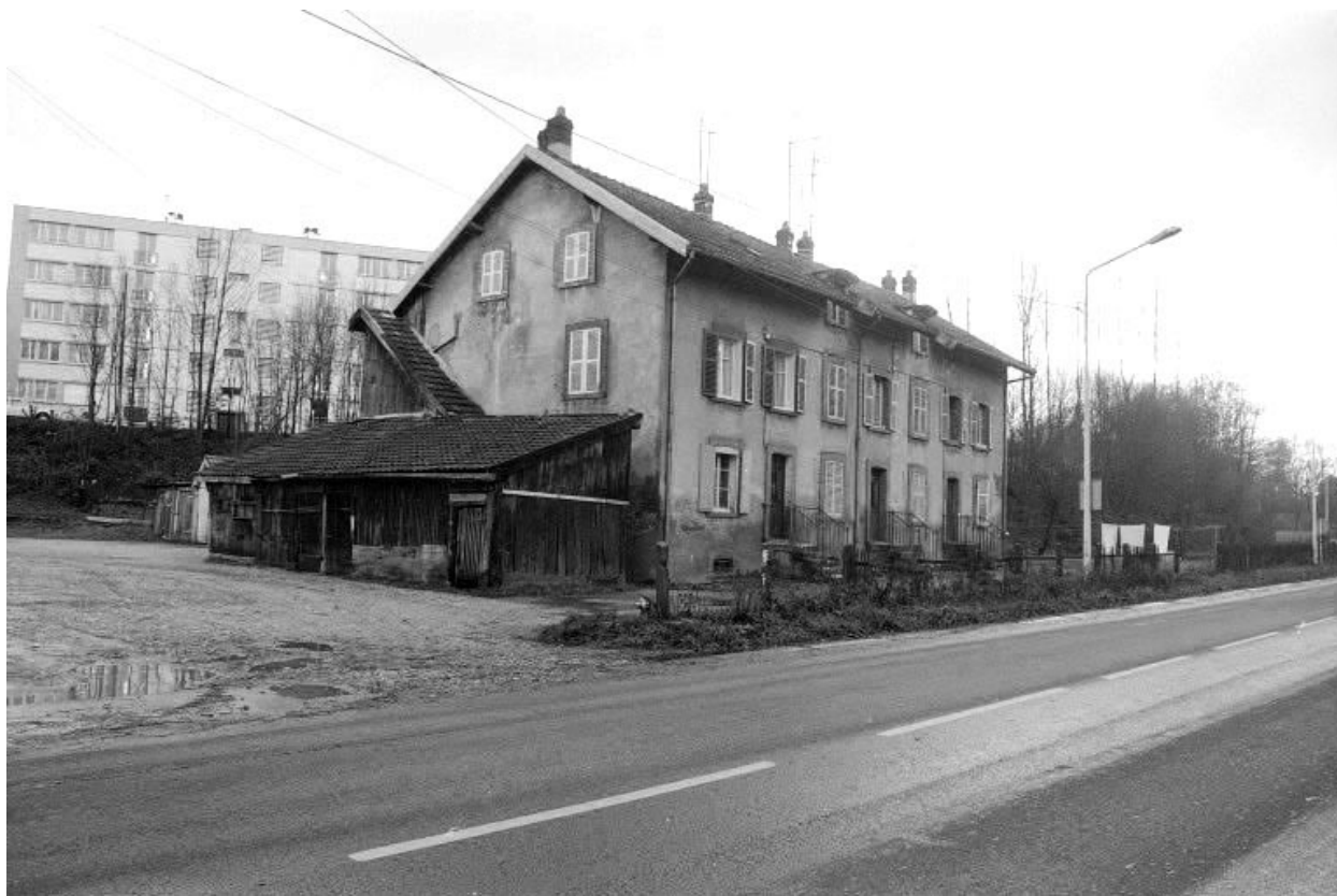
Vue de situation.
