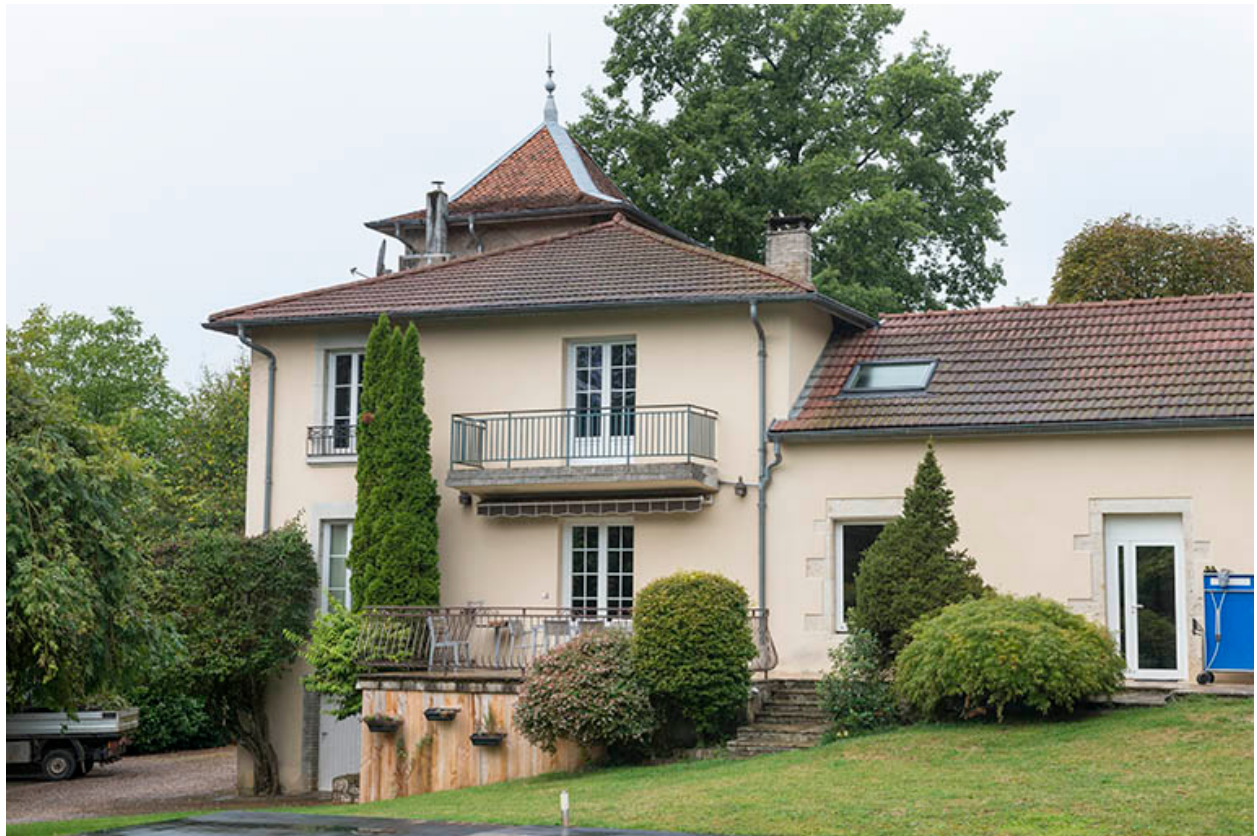
Partie sud de la façade côté parc.
