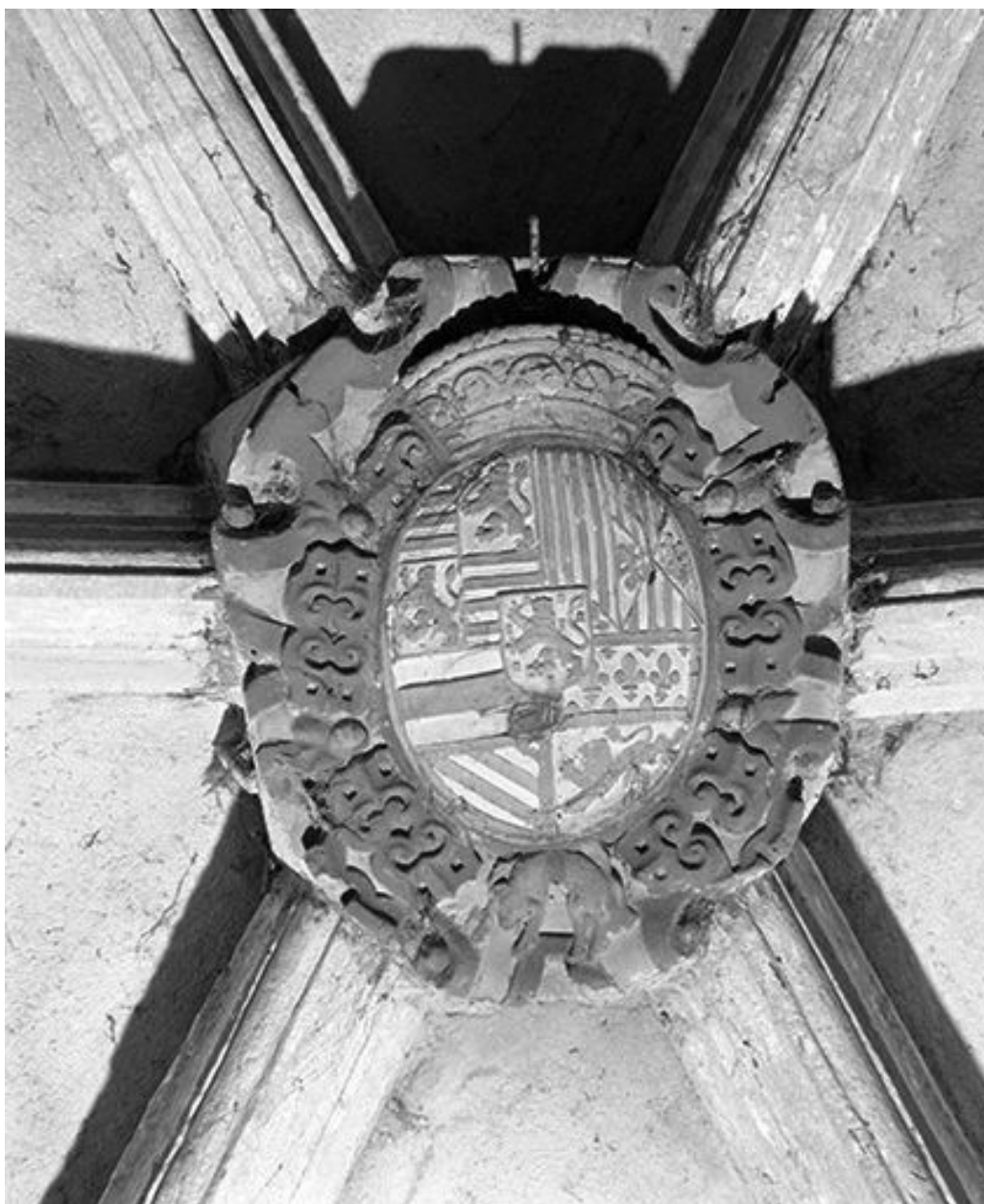
Clef de voûte du chœur.
