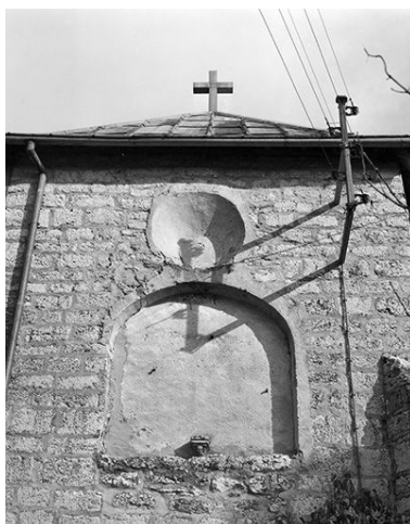
Baies murées du chevet.
