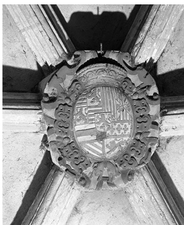
Clef de voûte du chœur. Phot. Yves Sancey IVR43_19782500789X
