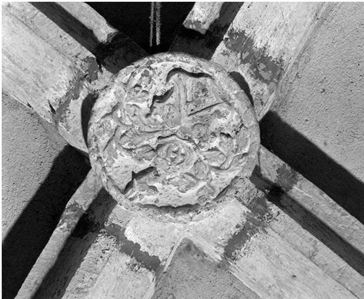
Clef de voûte du chœur.
