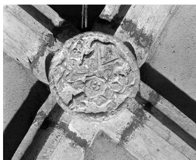
Clef de voûte du chœur. Phot. Yves Sancey IVR43_19782500791X
