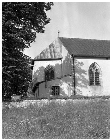
Façade latérale gauche du chœur.
