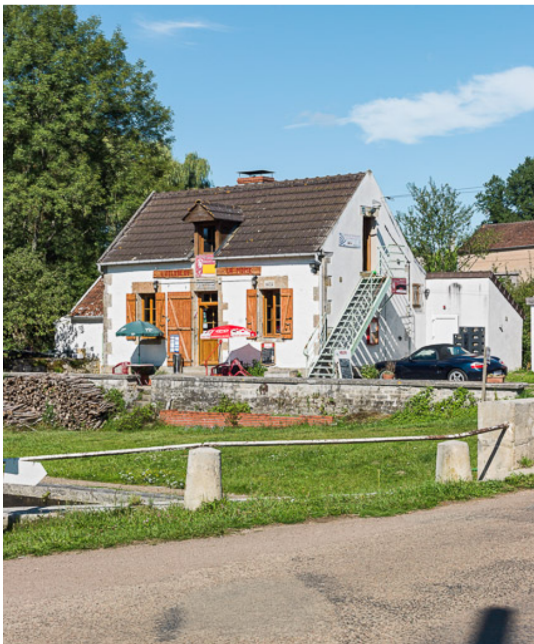
Vue de la maison éclusière.
