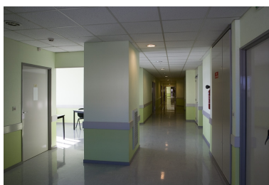
Site ancien, internat : couloir.
