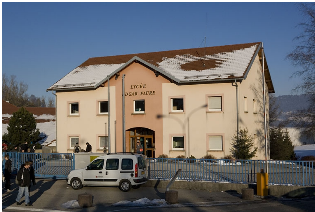
Site récent : l'entrée (administration et conciergerie).
