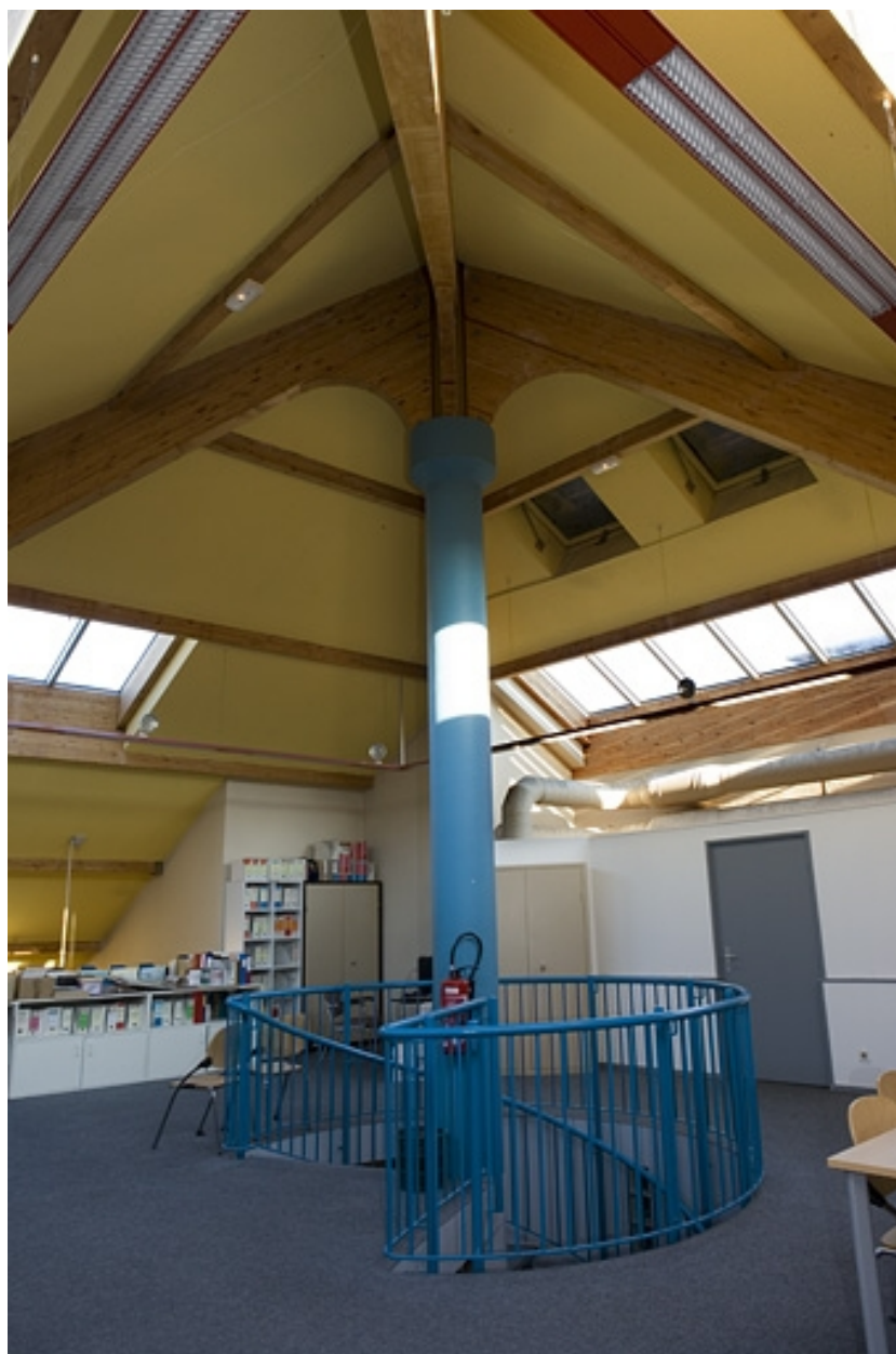
Site récent, centre de documentation (CDI) : escalier en vis desservant la tribune et colonne supportant la charpente.
