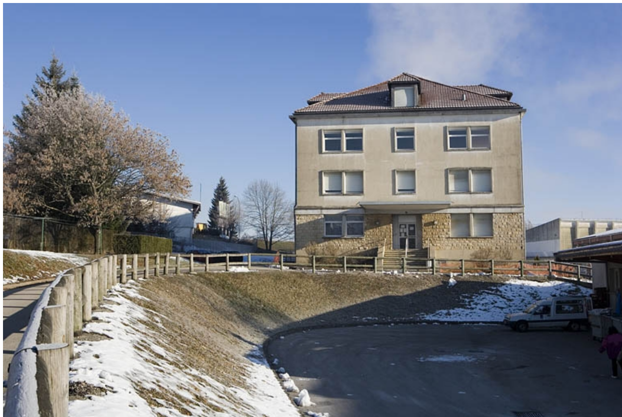
Site ancien, internat : mur pignon sud-ouest.
