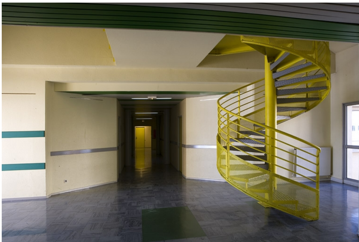
Site récent, bâtiment des salles d'informatique et du pôle bijouterie : escalier en vis reliant l'étage carré et l'étage en surcroît.
