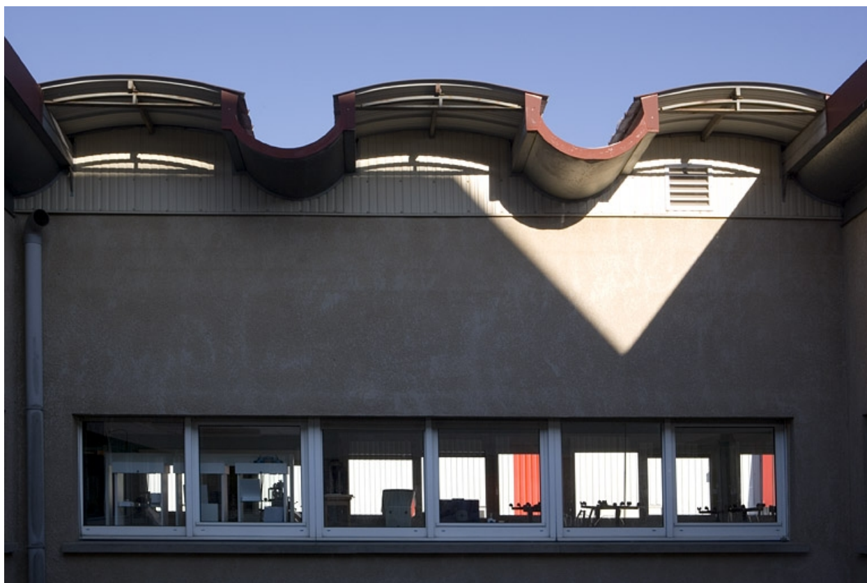
Site récent, atelier d'horlogerie : toiture.
