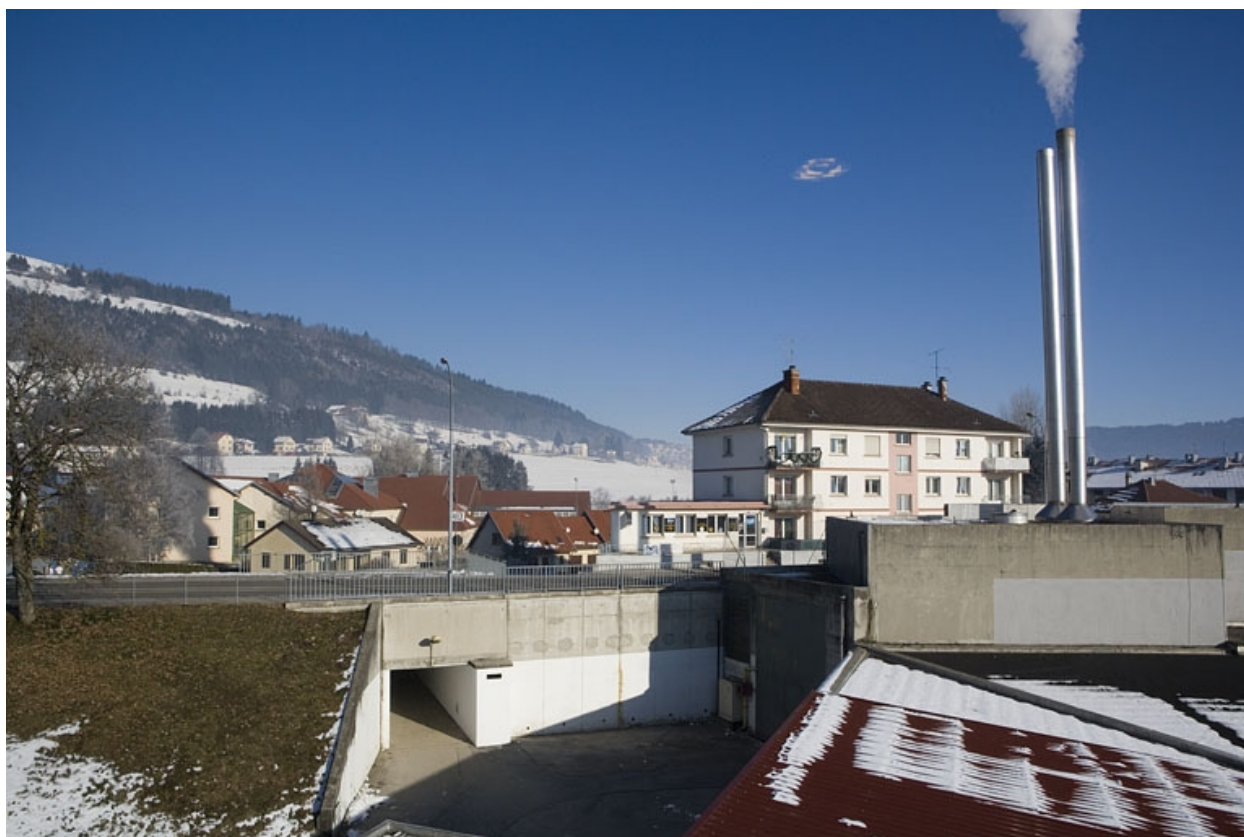
Site ancien : tunnel et chaufferie, depuis l'internat.
