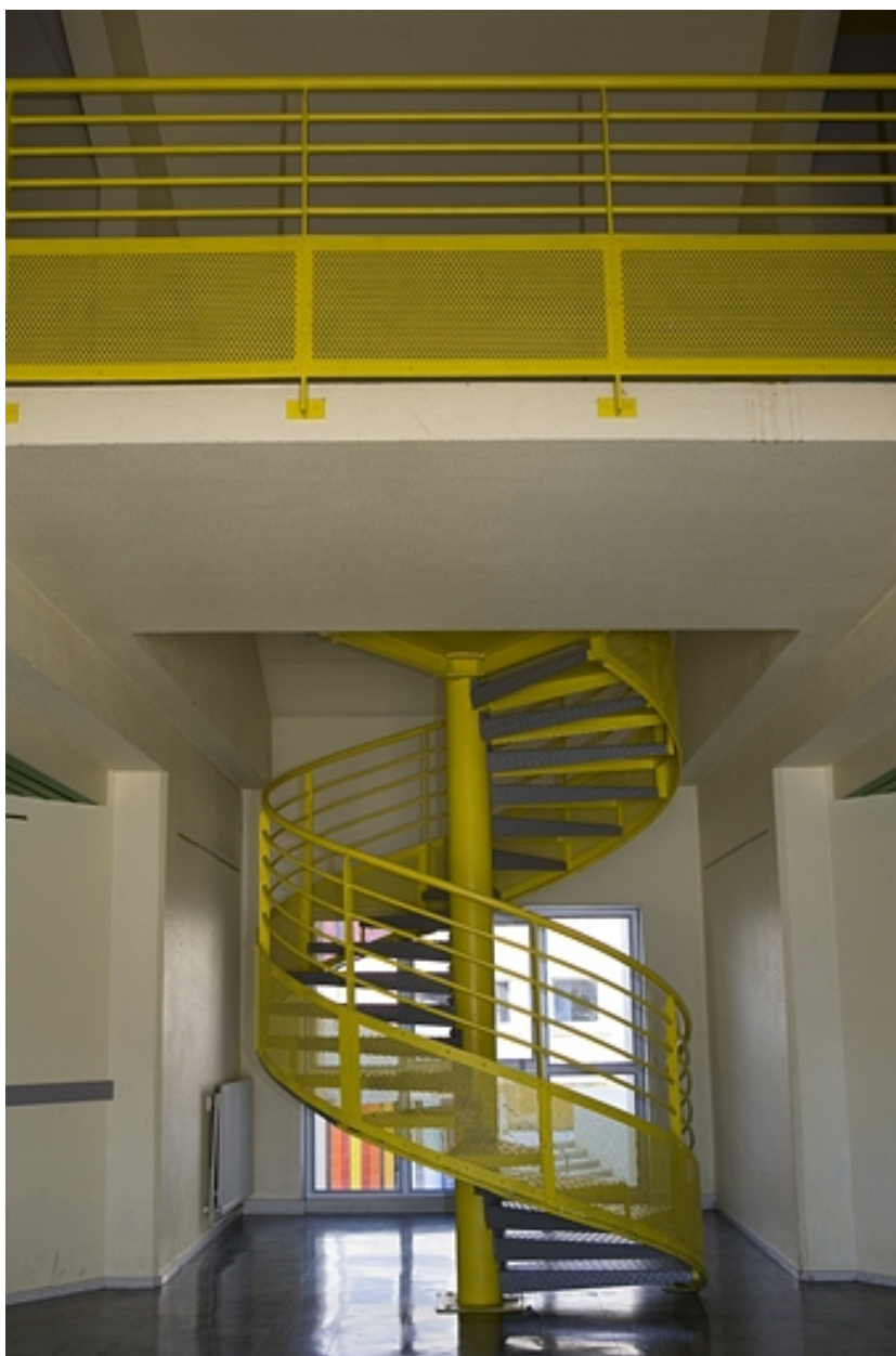
Site récent, bâtiment des salles d'informatique et du pôle bijouterie : escalier en vis et galerie à l'étage en surcroît.
