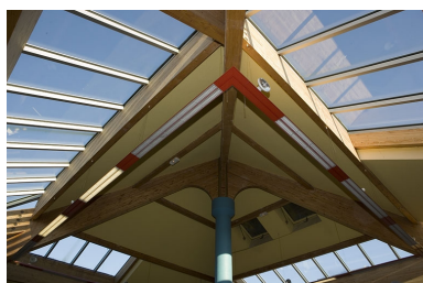
Site récent, centre de documentation (CDI) : charpente en lamellé-collé. Phot. Yves Sancey IVR43_20072501202NUCA
