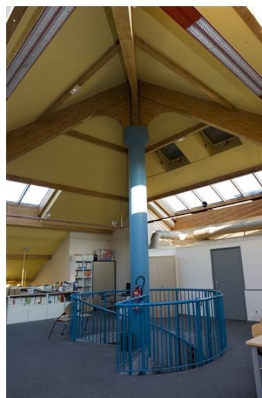
Site récent, centre de documentation (CDI) : escalier en vis desservant la tribune et colonne supportant la charpente. Phot. Yves Sancey IVR43_20072501201NUCA
