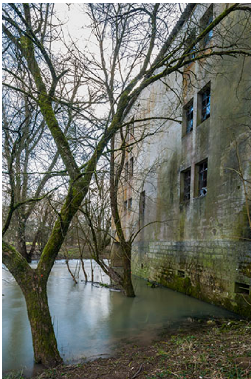
Façade nord du magasin industriel.
