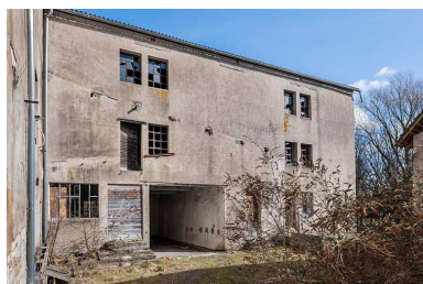
Façade sud du magasin industriel. Phot. Jérôme Mongreville IVR43_20152500333NUC4A
