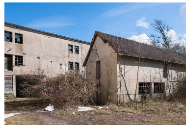
Magasins industriels à l'est. Phot. Jérôme Mongreville IVR43_20152500335NUC4A
