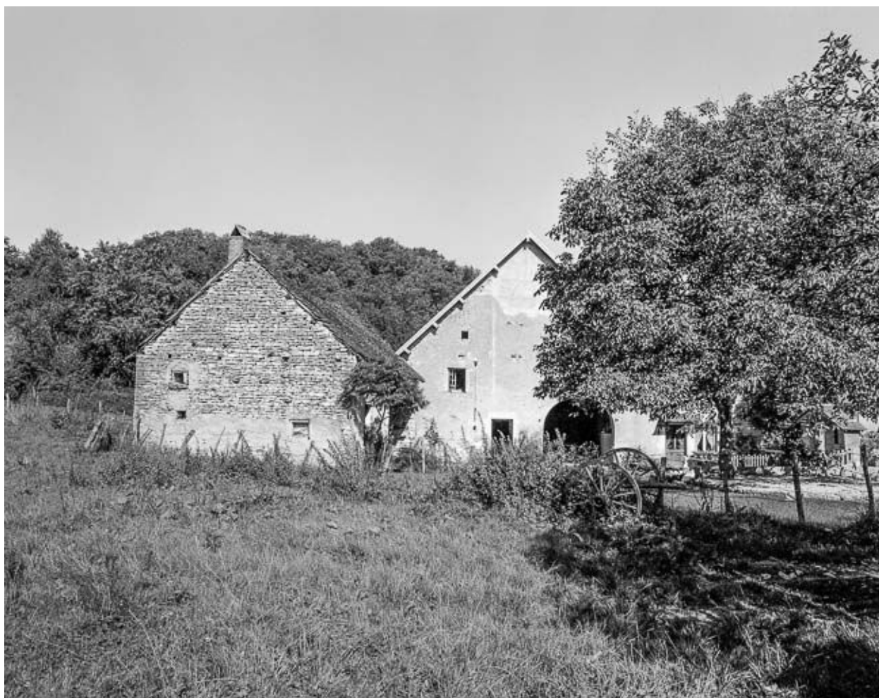
Façade sur cour et dépendances.
