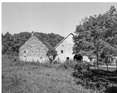
Façade sur cour et dépendances.
