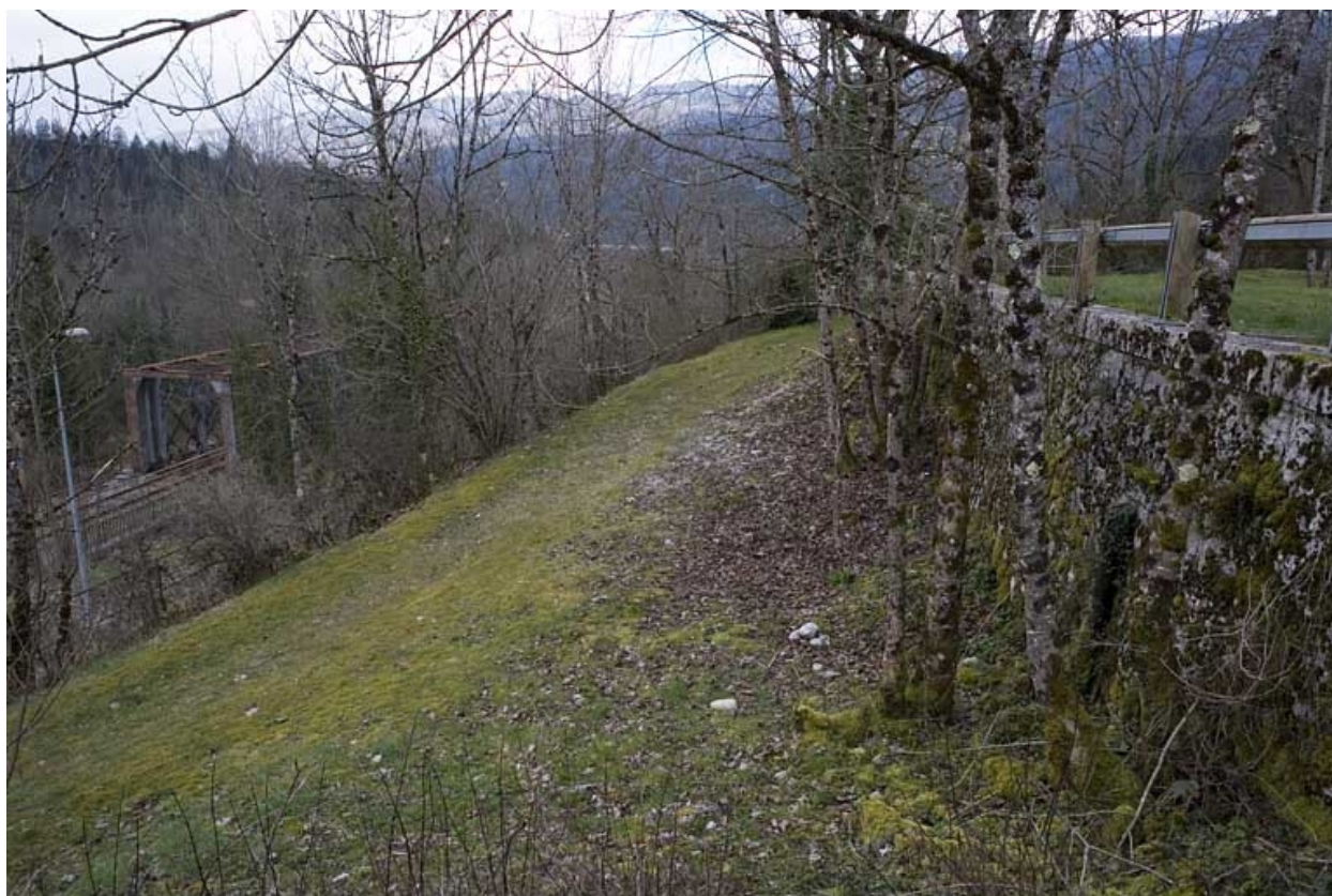
Réservoir (à droite) et son chemin d'accès.
