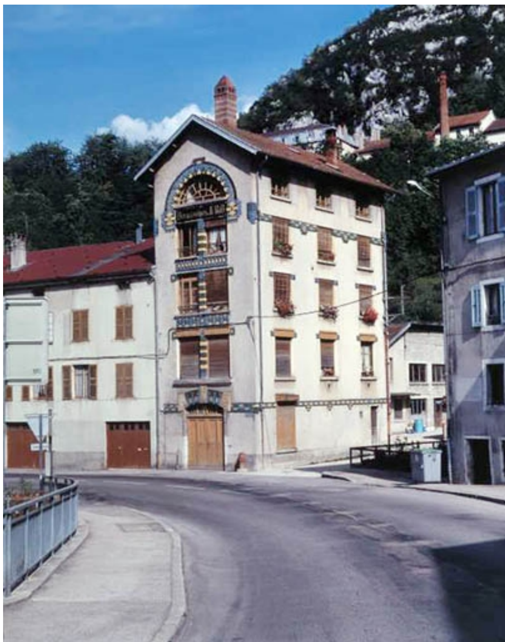
Logement sud de trois quarts droite.
