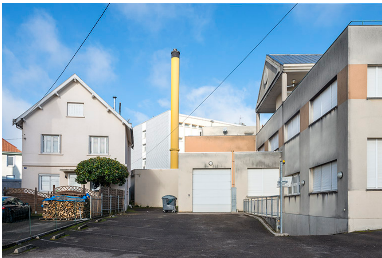
A l'extrémité sud du lycée, la chaufferie.
