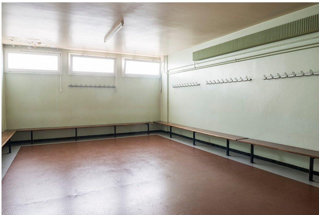
Vue intérieure d'un vestiaire du gymnase.
