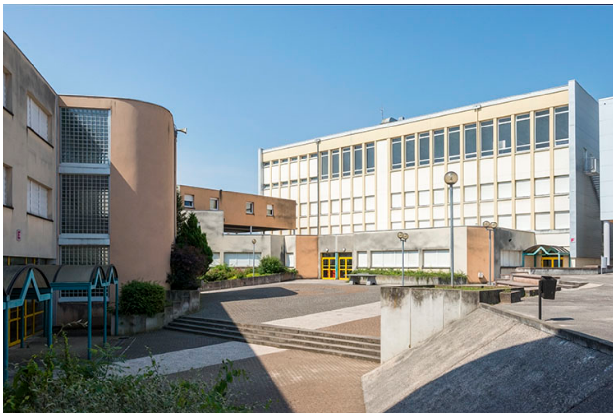
Partie sud de la cour.
