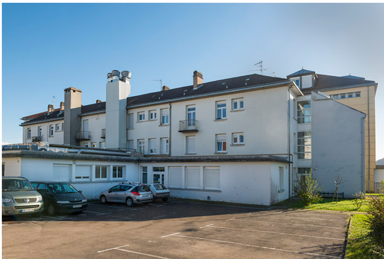
Façade nord de la restauration.
