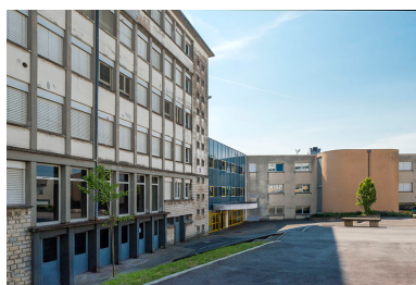
Dans la cour, angle intérieur est. Phot. Mary Ruffinoni IVR43_20142501492NUC4A
