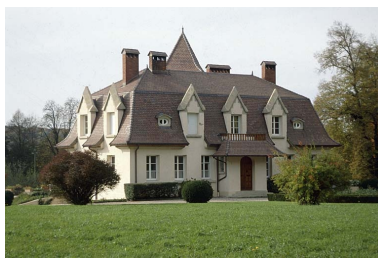
Façade postérieure. Phot. Yves Sancey IVR43_20009000849ZA
