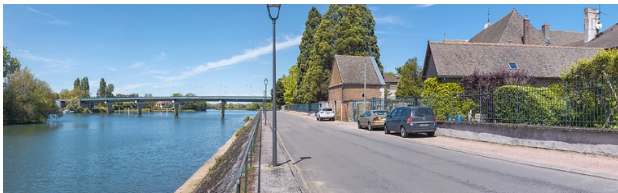
Vue d'ensemble du pont, depuis l'aval.
