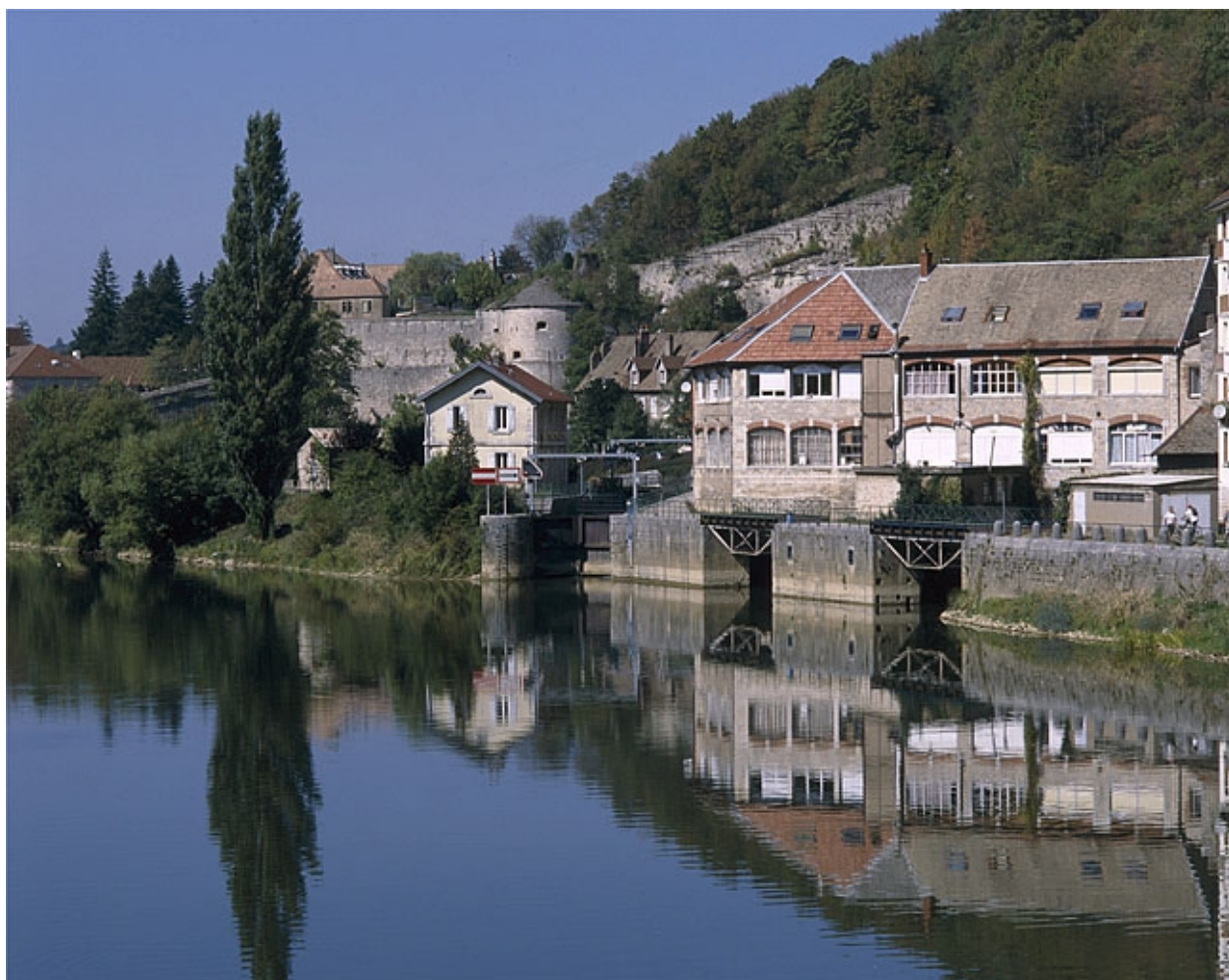
Vue d'ensemble, depuis l'aval.
