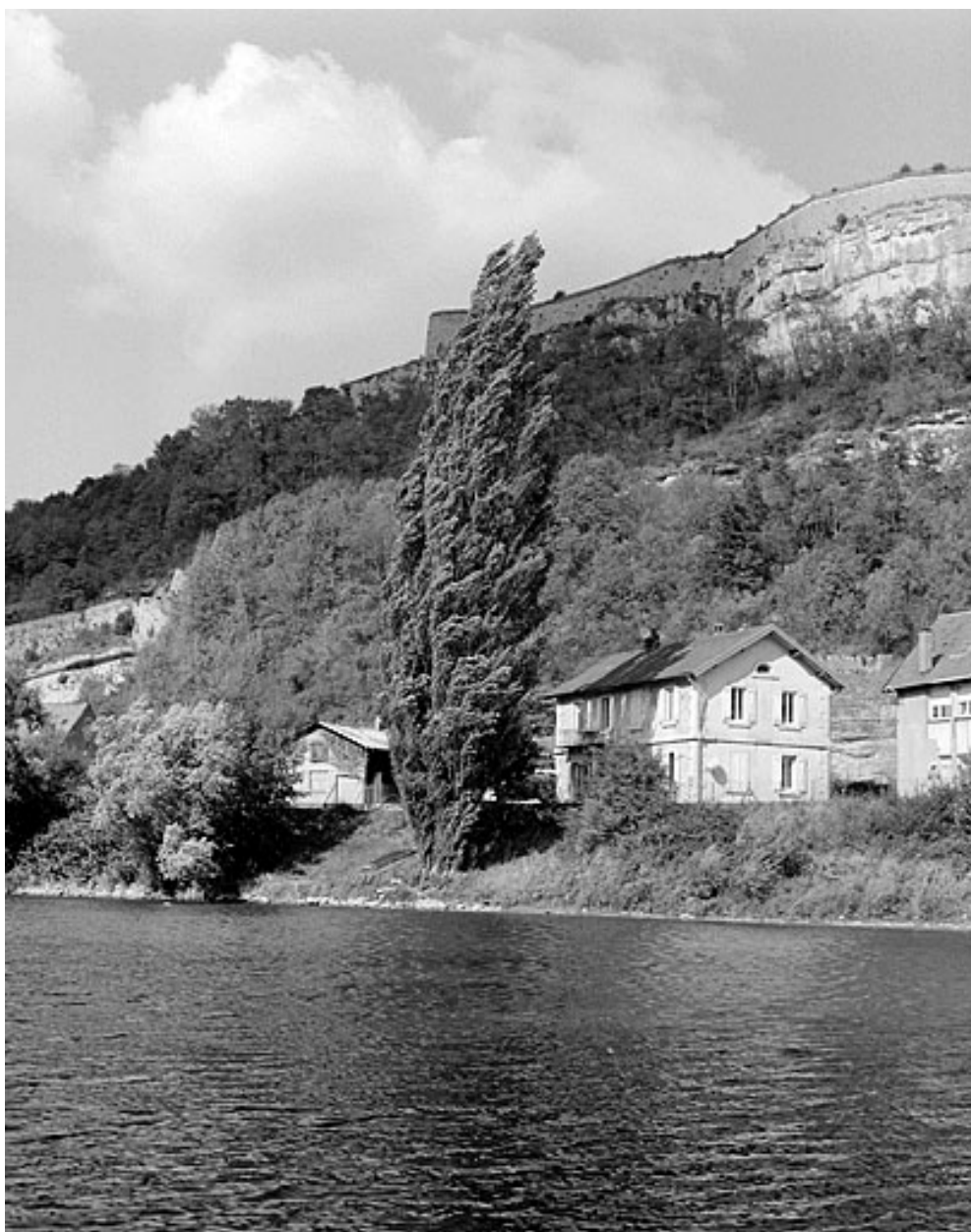
Façades postérieure et latérale gauche.
