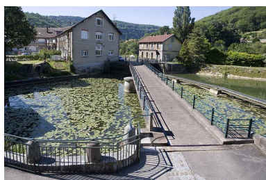
Vue d'ensemble, depuis l'amont. Phot. Yves Sancey IVR43_20062500215NUCA
