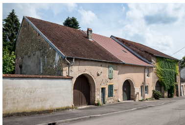
Vue générale. Phot. Jérôme Mongreville IVR43_20187000283NUC4A
