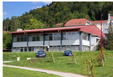
Façades antérieure et latérale gauche.
