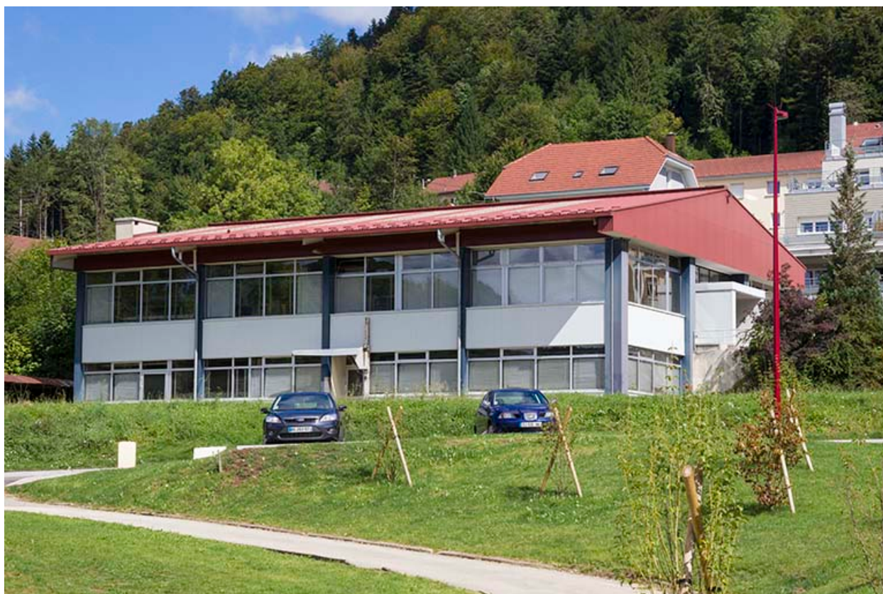
Façades antérieure et latérale gauche.
