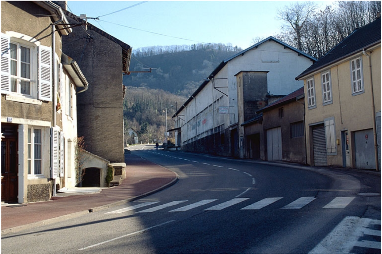
L'atelier de fabrication depuis l'ouest.
