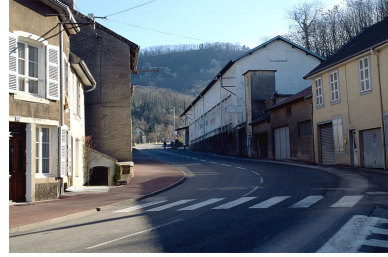
L'atelier de fabrication depuis l'ouest.
