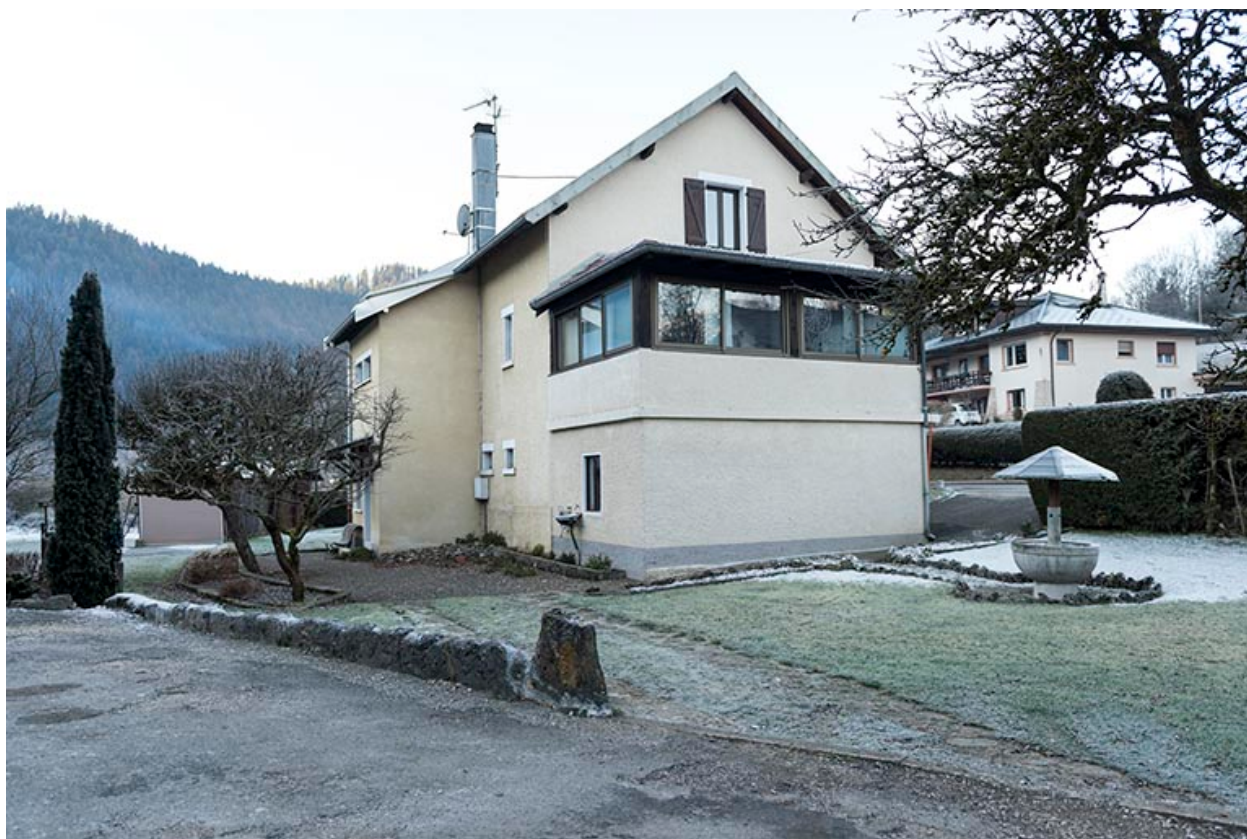
Façades postérieure et latérale gauche.
