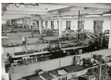
Hall de montage, vers 1965. IVR43_20162501097NUC4A
