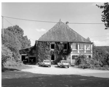
Façade ouest du logement. Phot. Yves Sancey IVR43_19973901425X
