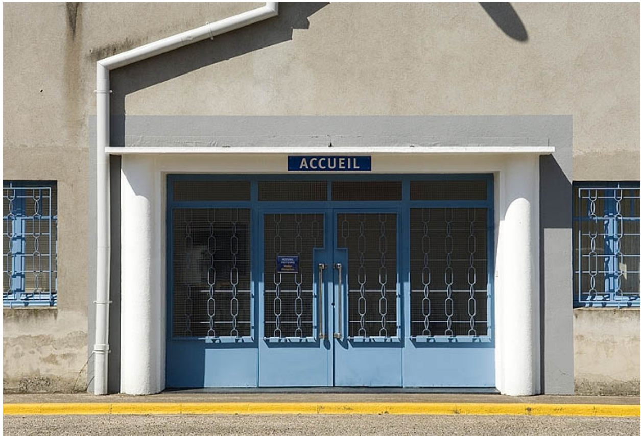
Façade des bureaux. Détail de l'entrée.
