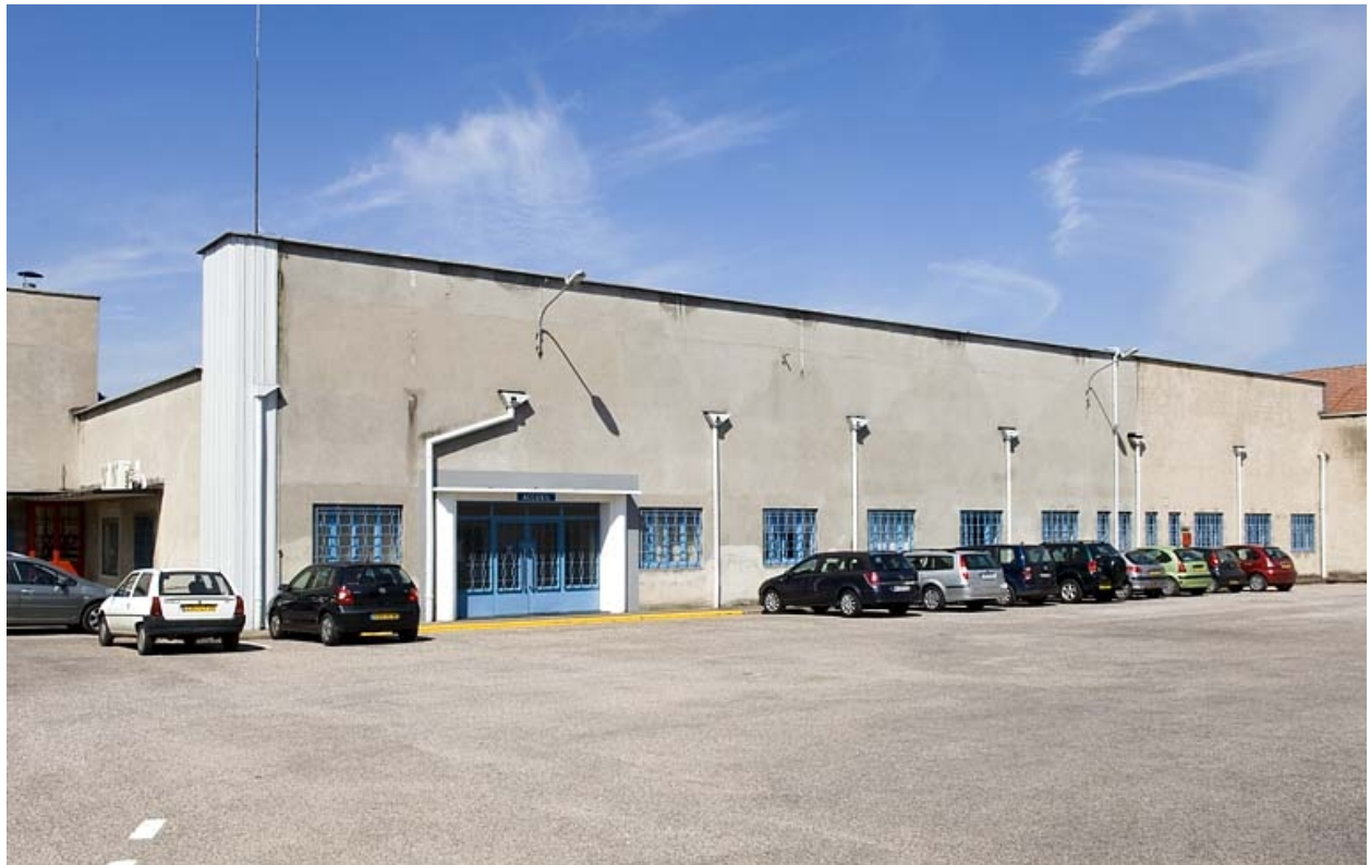
Façade des bureaux.
