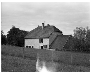
Ferme située chemin de la Muyre : vue d'ensemble. Phot. Yves Sancey
