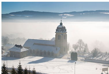
Vue plongeante sur l'église et le cimetière. Phot. Sonia Dourlot IVR43_20152500033NUC2A
