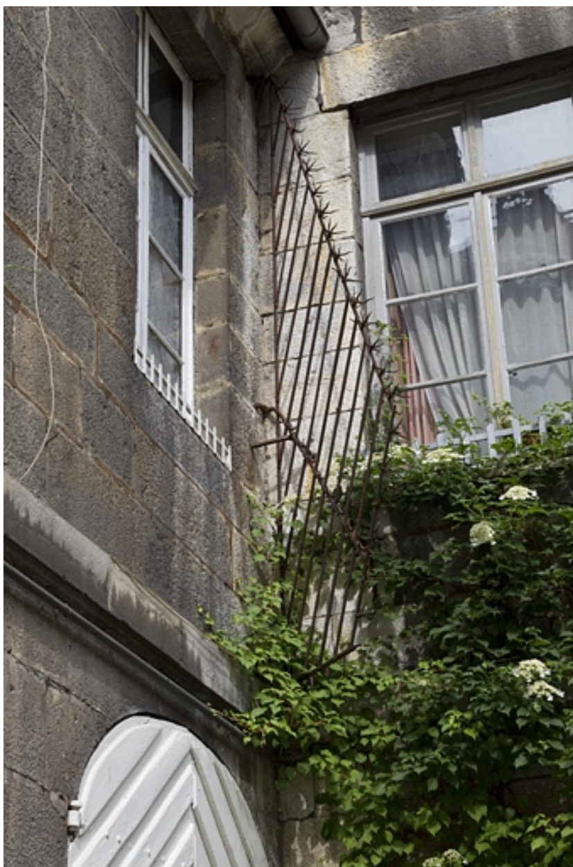
Cour : détail d'une grille de protection.
