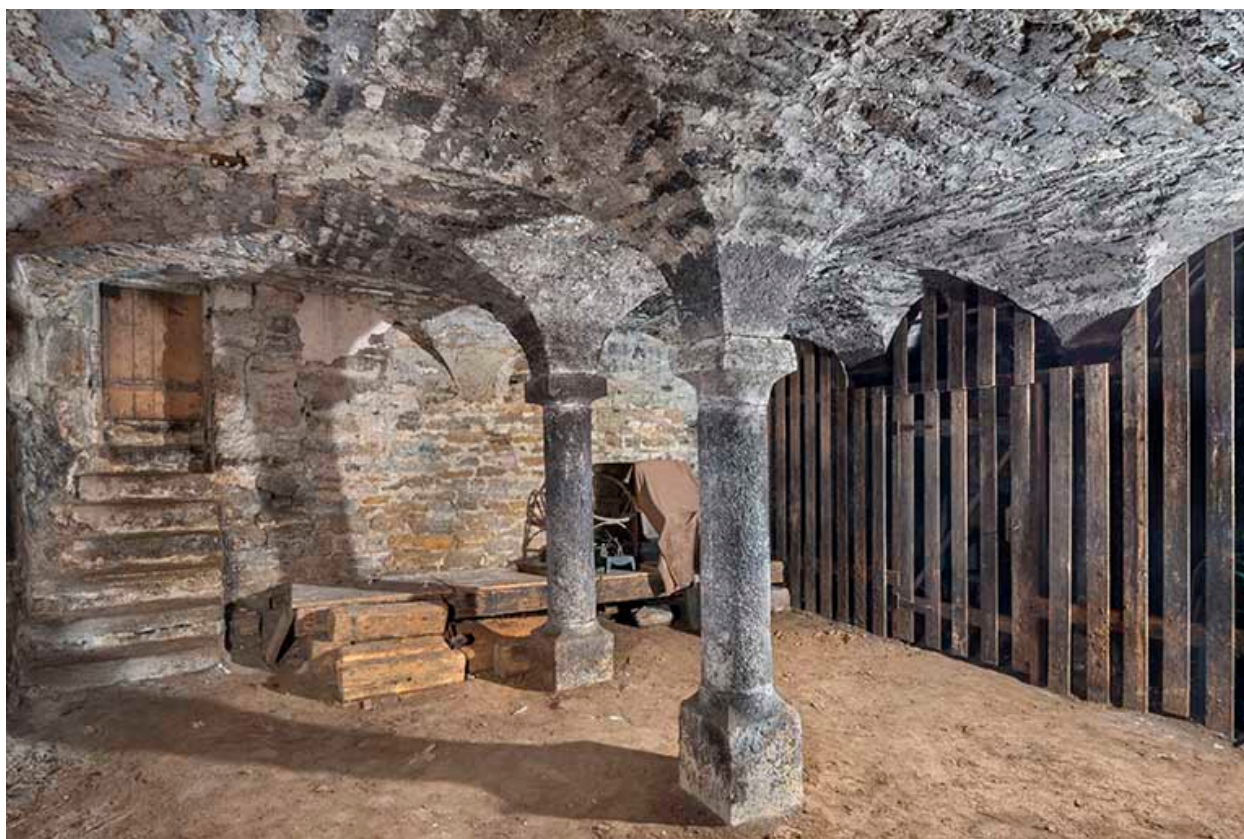
Vue d'ensemble de la cave depuis l'ouest.
