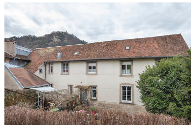
Façade postérieure. Phot. Jérôme Mongreville IVR43_20233900121NUC4A
