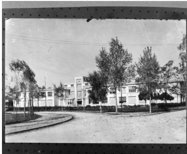
Façade antérieure. Phot. Jérôme Mongreville, Phot. Charnotet IVR43_19903900108X
