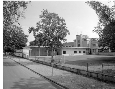
Façade postérieure, vue de trois quarts. Phot. Yves Sancey IVR43_19893900353X
