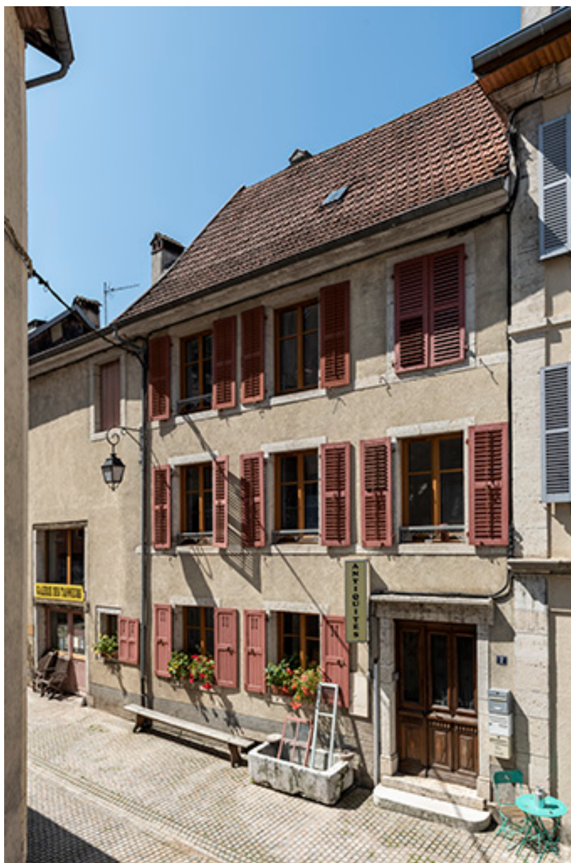
Immeuble 2 rue Jacques Courtois.
