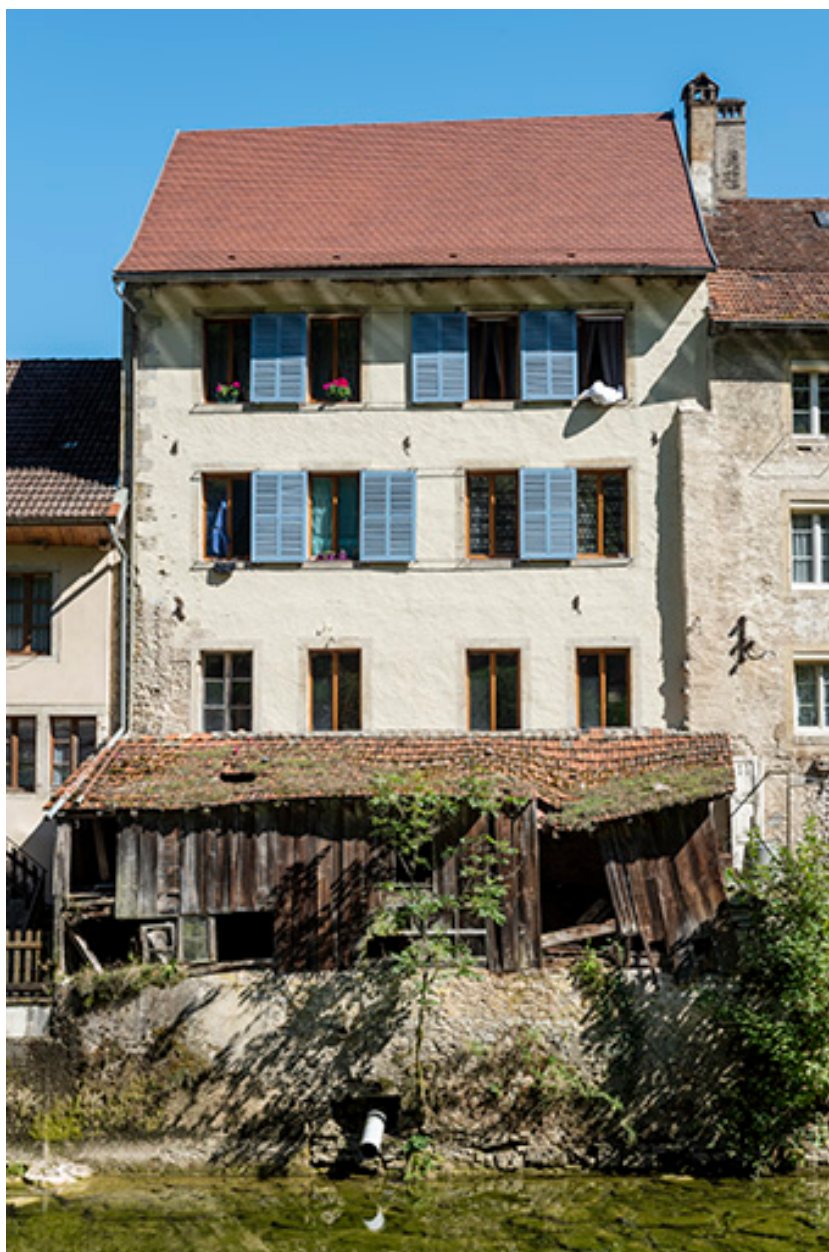
Immeuble 3 place du Chapitre : façade postérieure.
