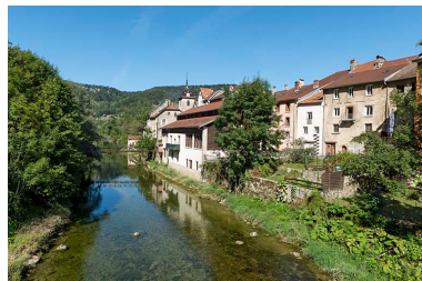
Vue d'ensemble, depuis le pont au sud. Phot. Sonia Dourlot
