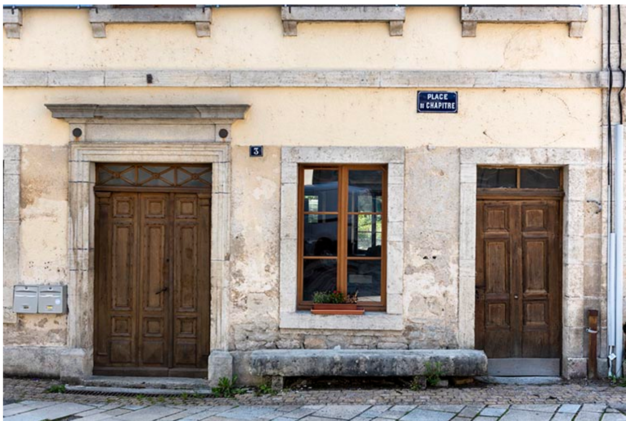
Immeuble 3 place du Chapitre, façade antérieure : entrée.
