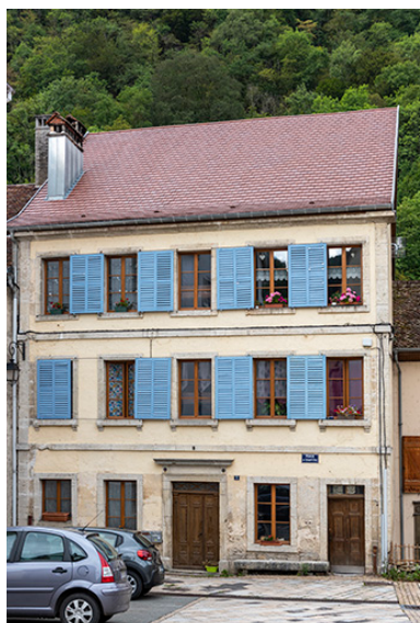
Immeuble 3 place du Chapitre : façade antérieure. Phot. Sonia Dourlot IVR43_20192501481NUC4A
