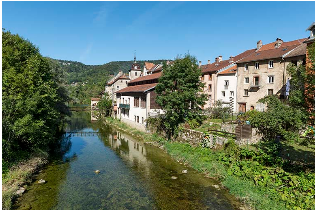
Vue d'ensemble, depuis le pont au sud.
