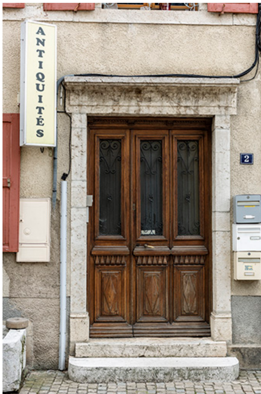
Immeuble 2 rue Jacques Courtois : entrée.
