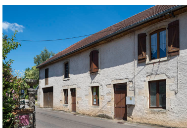
Élévation sur la rue. Phot. Jérôme Mongreville IVR43_20187000347NUC4A
