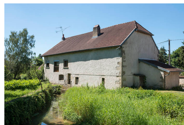
Élévation sur le ruisseau. Phot. Jérôme Mongreville IVR43_20187000341NUC4A
