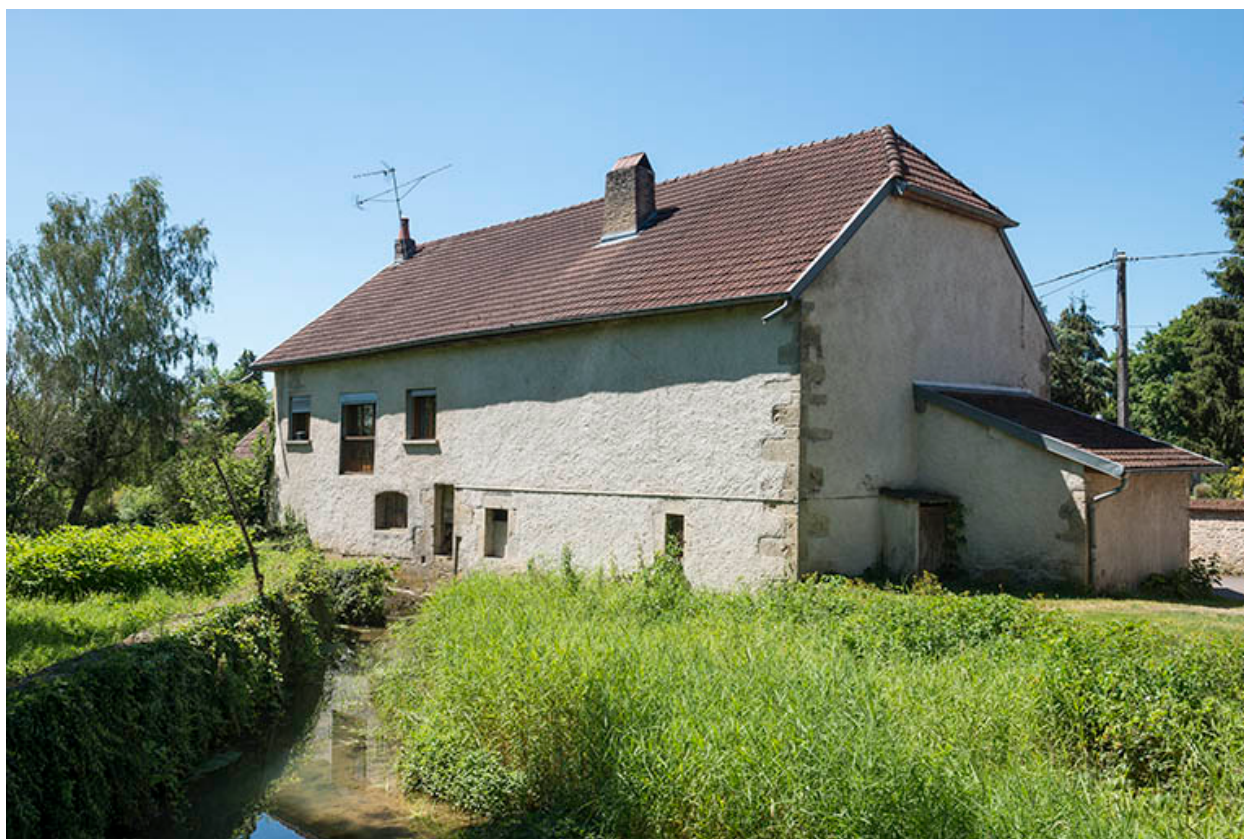
Élévation sur le ruisseau.
