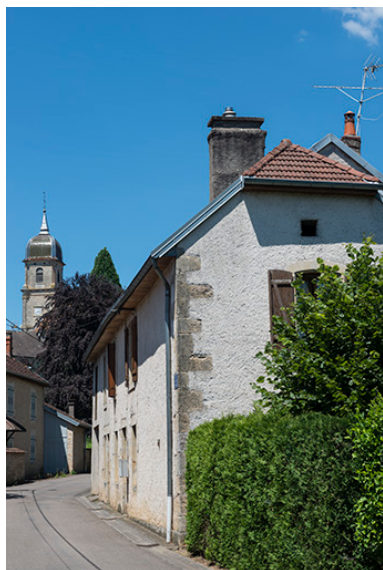
Élévation sur la rue. Phot. Jérôme Mongreville IVR43_20187000348NUC4A
