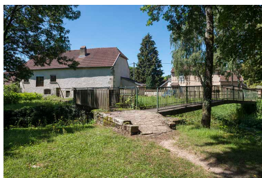
Élévation sur le ruisseau. Phot. Jérôme Mongreville IVR43_20187000344NUC4A
