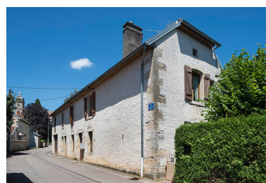
Élévation sur la rue. Phot. Jérôme Mongreville IVR43_20187000346NUC4A
