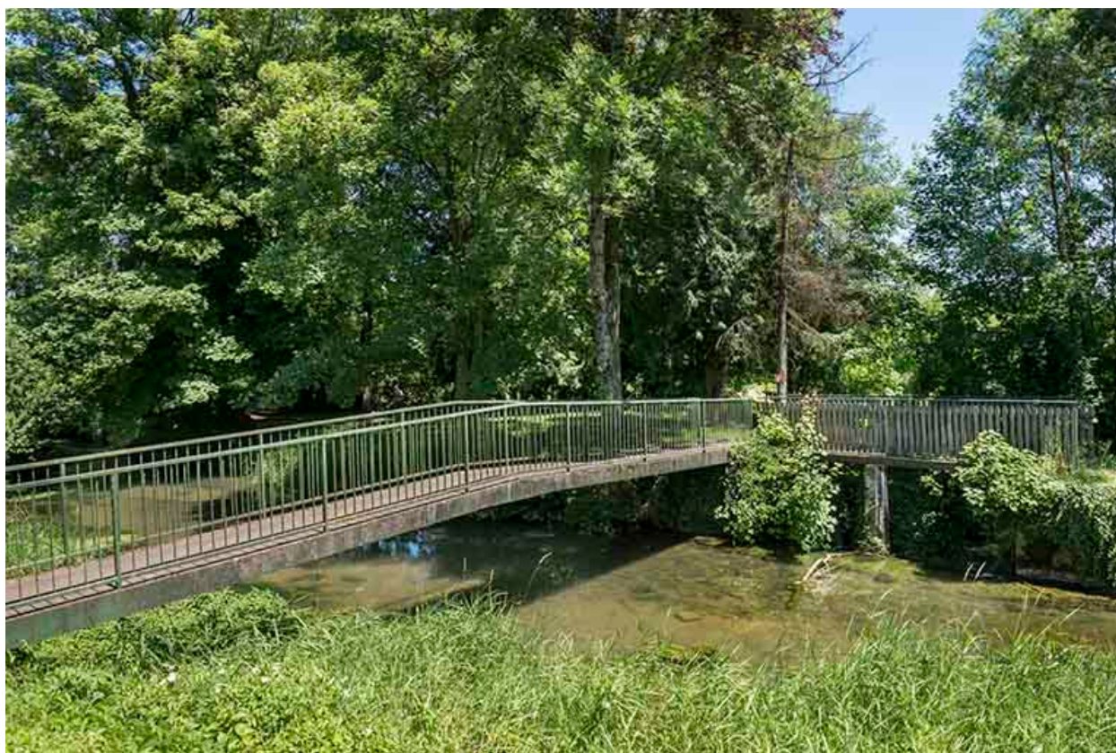
Passerelle au-dessus du ruisseau.
