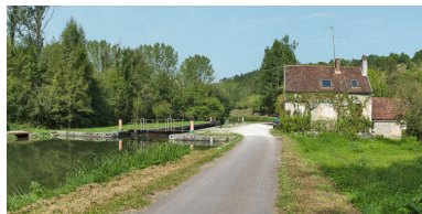
Vue du site d'écluse. Phot. Pierre-Marie Barbe-Richaud IVR26_20178900124NUC2AQ
