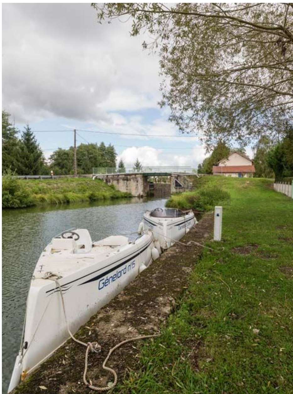
Vue d'ensemble du pont.
