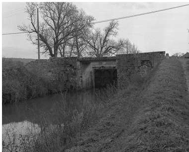
L'écluse et le pont. Phot. Jean-Luc Duthu IVR26_19925800269X
