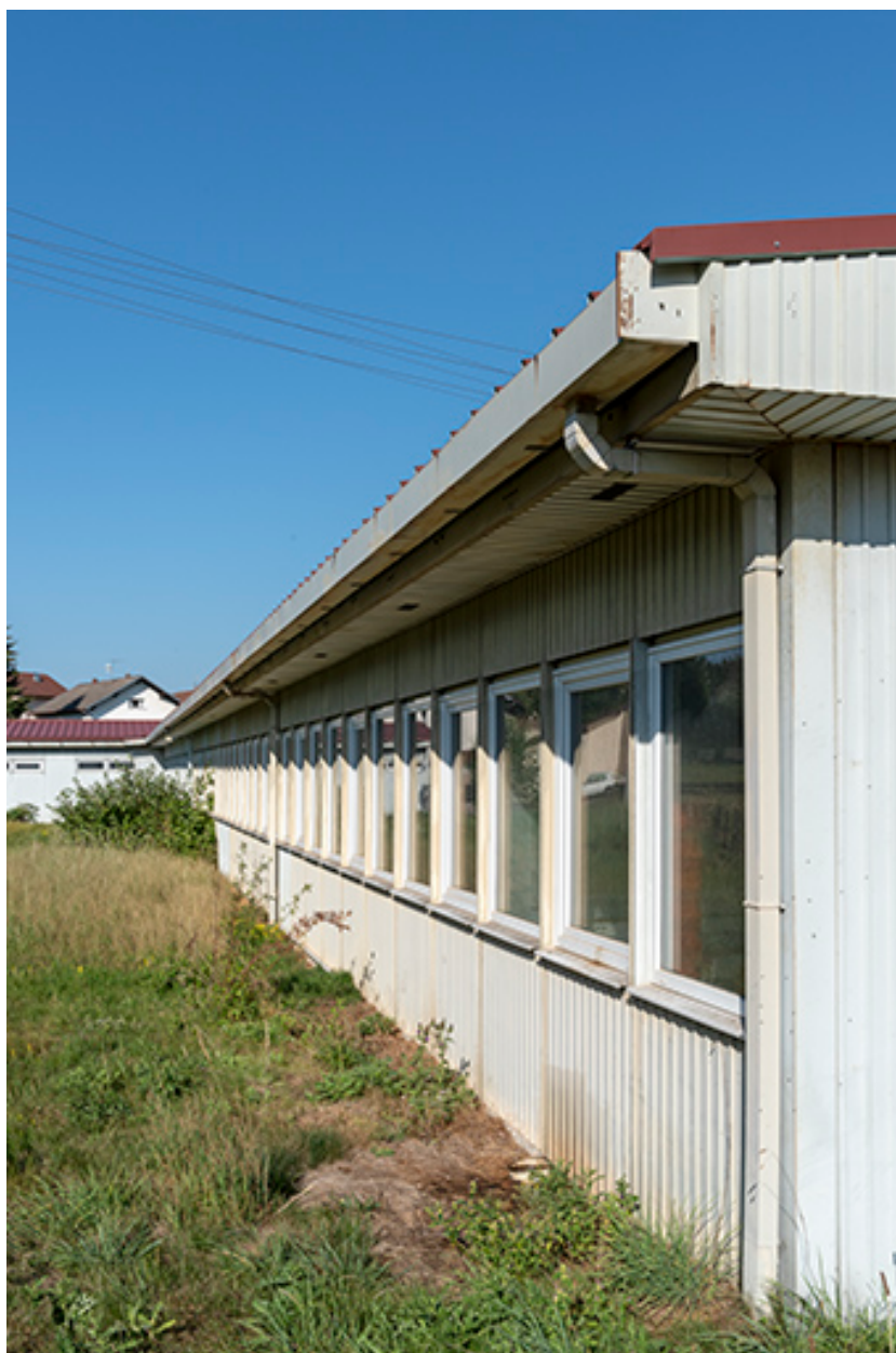
Façade postérieure, vue en enfilade.
