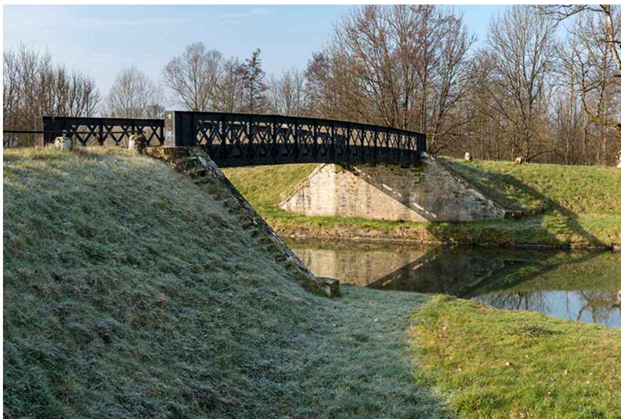
Pont du Devez.
