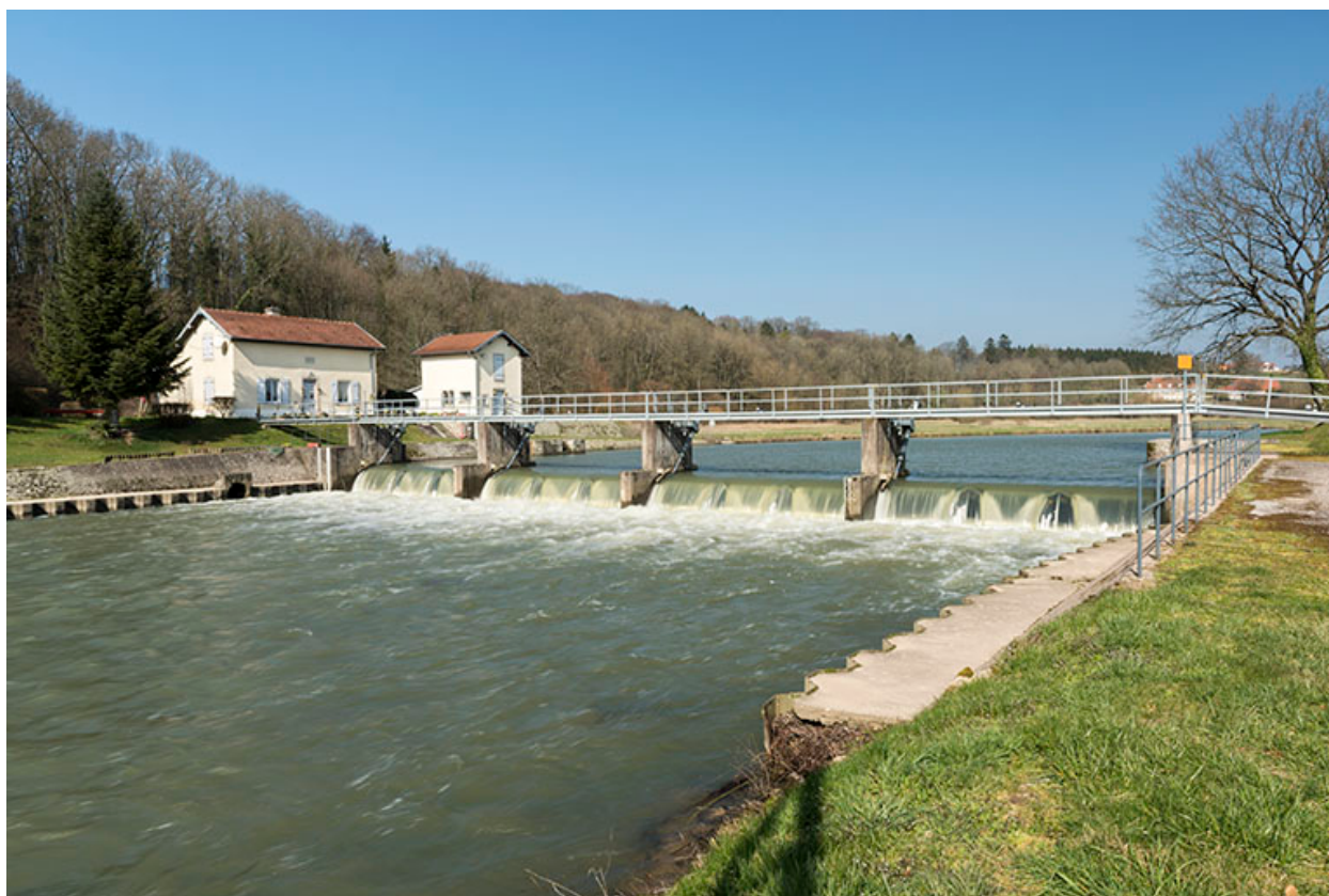
Le site du barrage mobile, vue d'ensemble.
