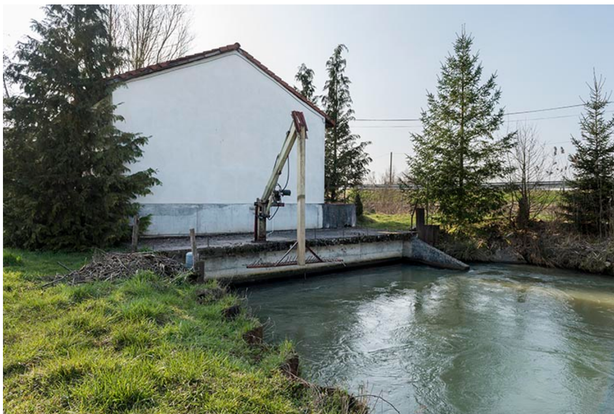
Appareil lié à l'entretien du bief.
