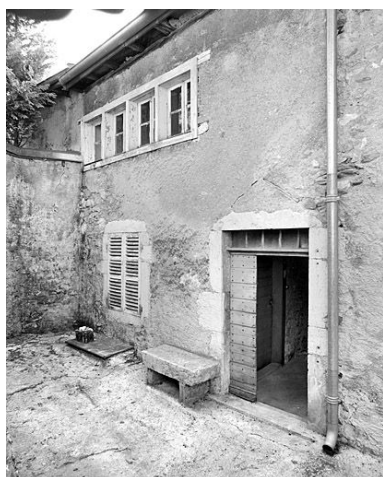
Façade postérieure du bâtiment oriental. Phot. Yves Sancey IVR43_20033900609X
