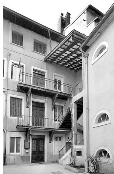
Façade postérieure et escalier. Phot. Yves Sancey
