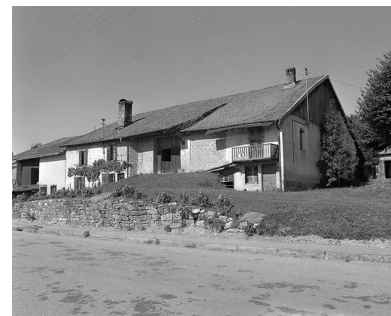
Ferme située 7 rue Saint-Martin. Phot. Yves Sancey IVR43_19802500939X
