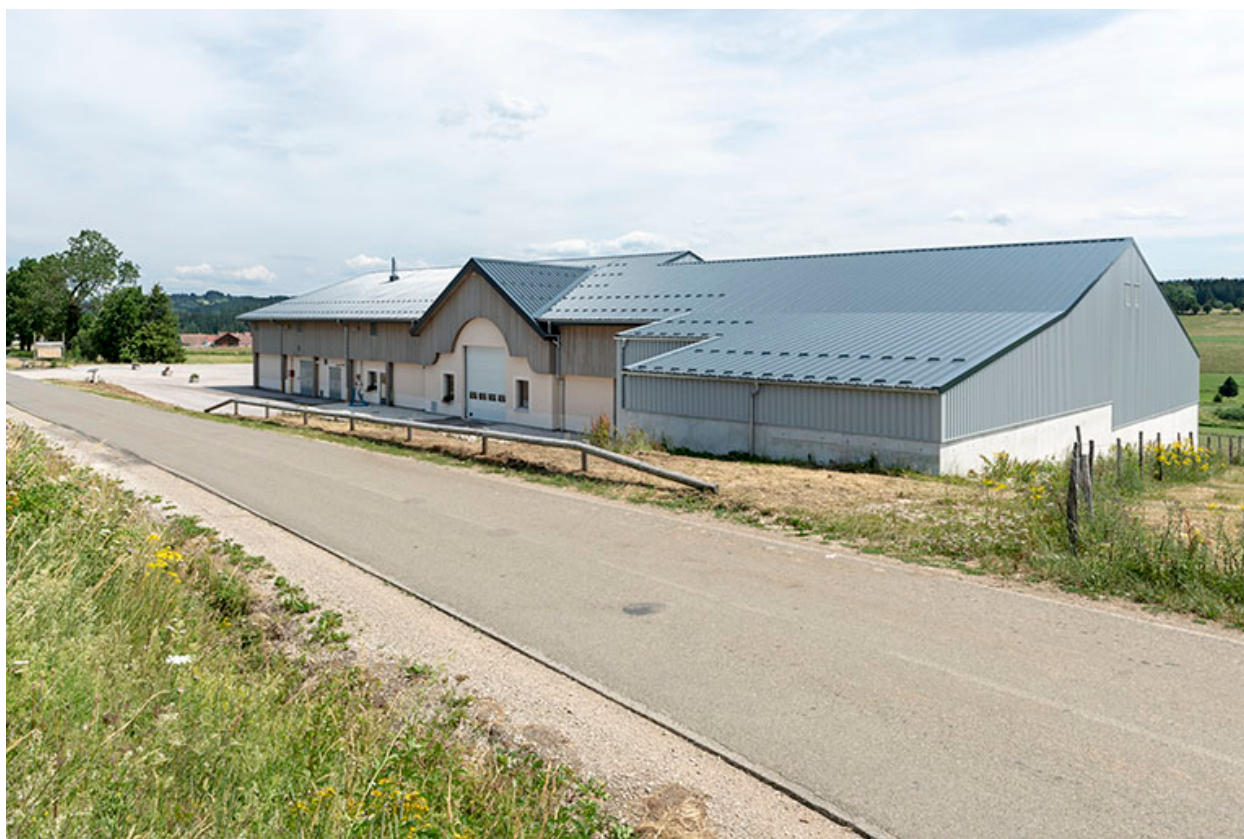
Façades postérieure et latérale droite.
