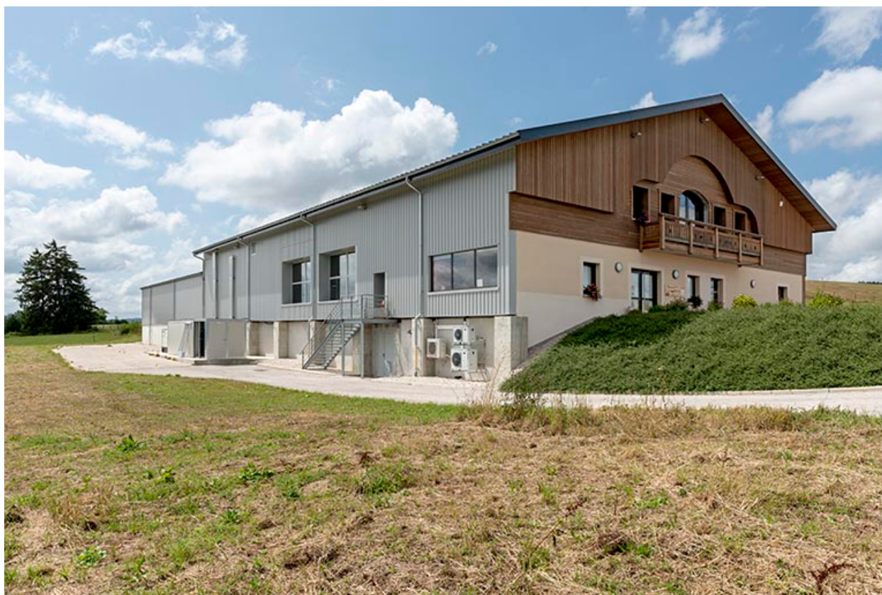
Façades antérieure et latérale gauche.
