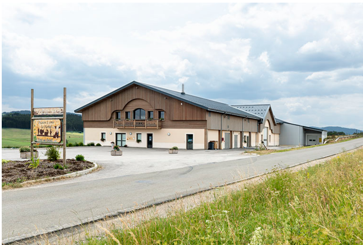
Façades antérieure et latérale droite.
