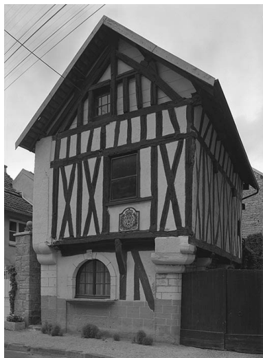
Mur-pignon sur rue. Phot. Michel Thierry IVR26_19748901163V
