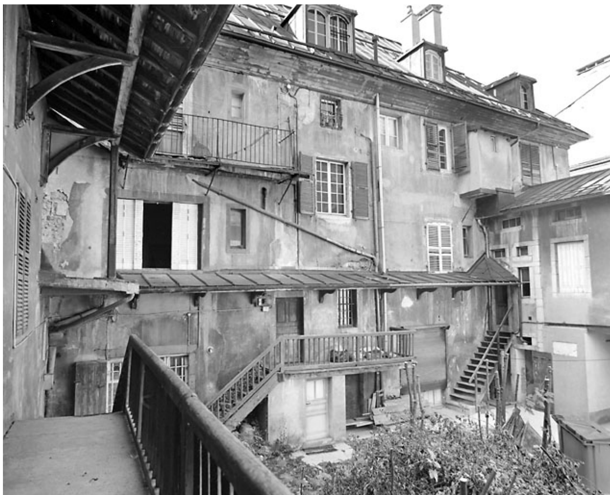
Elévation postérieure, de trois quarts gauche.
