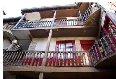
Détail des coursiers prolongeant l'escalier à cage ouverte. Phot. Yves Sancey IVR43_20092500262NUC2A
