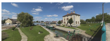
Ensemble du site vu d'aval. Phot. Thierry Kuntz IVR26_20112103341NUC4A
