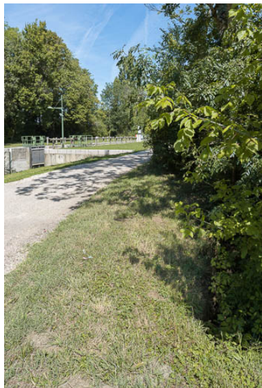
Vue de l'aqueduc.
