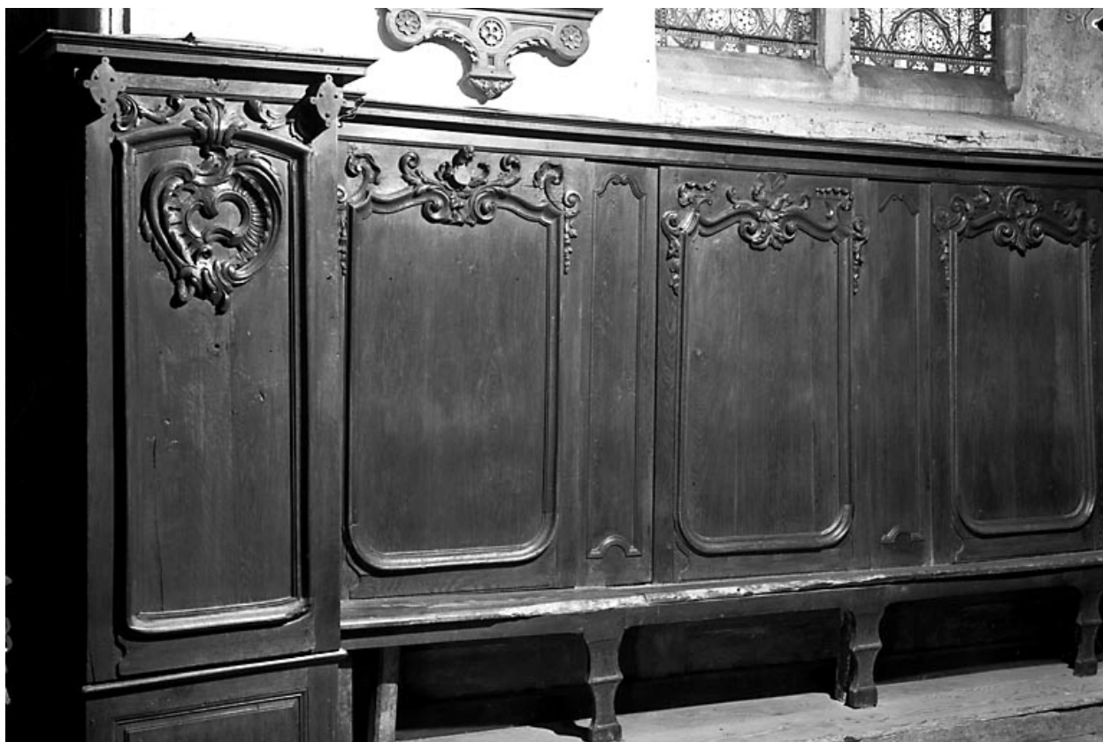
Lambris de demi-revêtement : côté nord.
