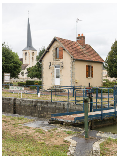
Le sas et la maison éclusière.
