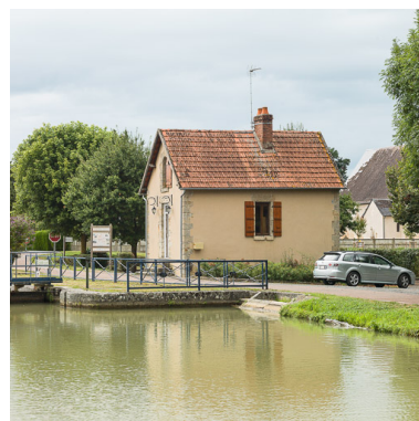
Vue de la maison éclusière. Phot. Pierre-Marie Barbe-Richaud IVR26_20175800230NUC2A
