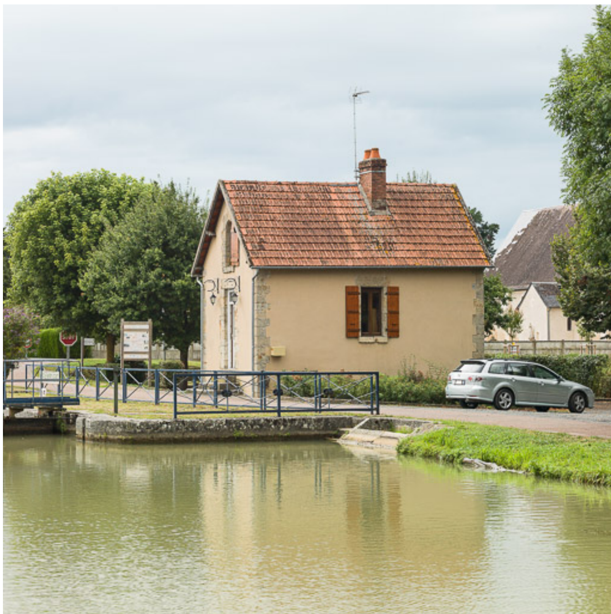
Vue de la maison éclusière.
