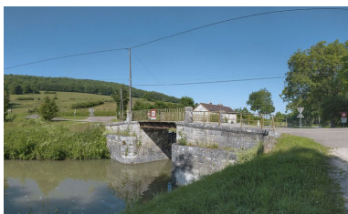
Pont vu d'aval.
