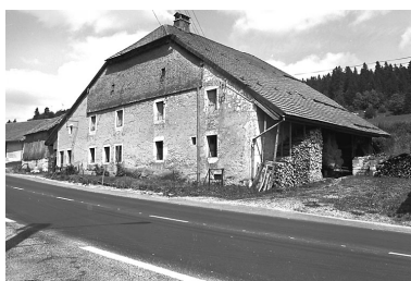
Ferme située aux Hôpitaux-Neufs. Phot. Dominique Dominguez IVR43_19792500960X
