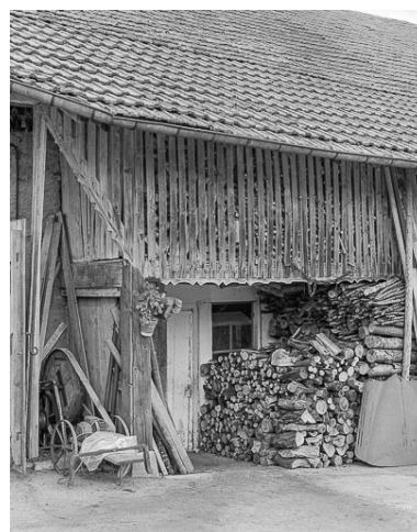
La Planée : galerie en bois contre un mur goutterot. Phot. Dominique Dominguez IVR43_19792500993X
