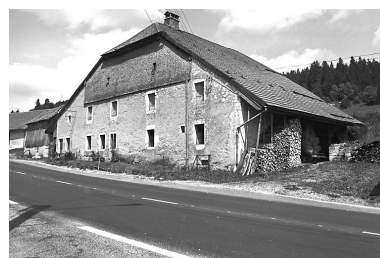
Les Hôpitaux-Neufs : grande ferme du 18e siècle à toit à deux versants et petites croupes, pignon sur rue, de structure typique de la région (4 travées parallèles aux pignons. Une "montée de grange" contre le goutterot gauche, permet d'accéder à la "grange haute". Phot. Dominique Dominguez IVR43_19792500960X
