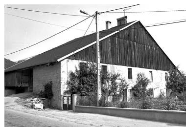
Dommartin : ferme située 4 rue de la Montagne. Le débord du toit sur rue protège les entrées de la "grange haute" et de l'étable. Phot. Dominique Dominguez IVR43_19792500869X
