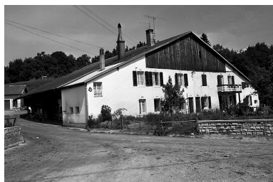
Ferme située aux Grangettes. Phot. Dominique Dominguez IVR43_19792500952X
