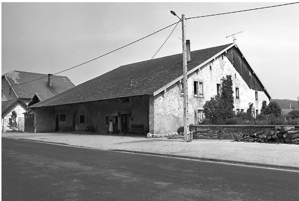
Houtaud : le débord du toit protégeant le mur goutterot sur rue s'appuie sur le prolongement des murs goutterots.
