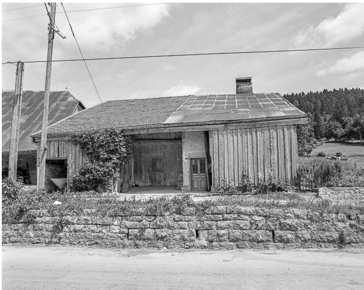
Les Hôpitaux-Vieux : petite ferme du 17e siècle divisée en trois travées parallèles aux pignons (habitation, grange et étable).
