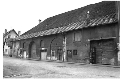
Pontarlier : ferme située 10-12 rue Colin. Phot. Yves Sancey IVR43_19802500249X
