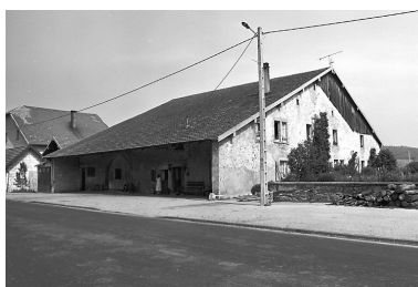
Houtaud : le débord du toit protégeant le mur goutterot sur rue s'appuie sur le prolongement des murs goutterots. Phot. Dominique Dominguez IVR43_19792500910X
