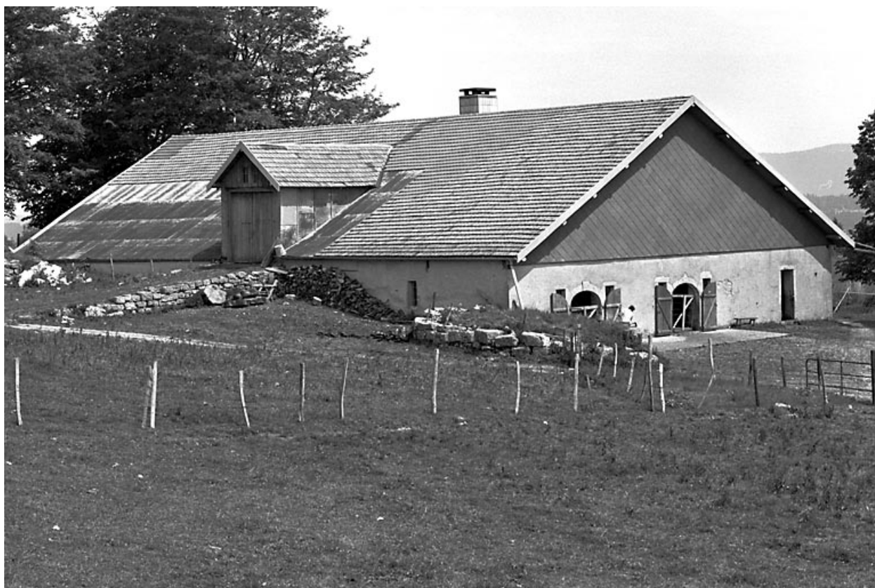
Pontarlier : ferme située au lieudit La Grange des Miroirs.
