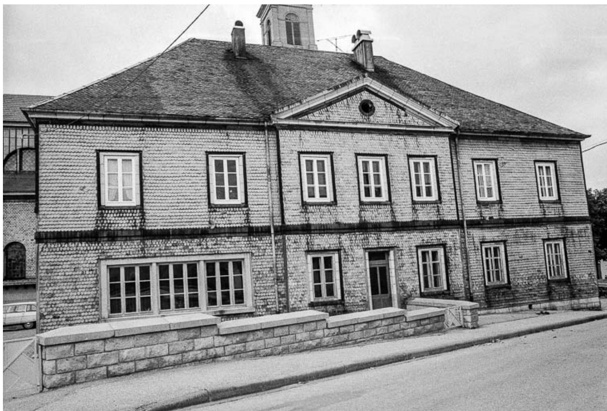
Ferme cadastrée 1975 F2 467, datée de 1854 : façade antérieure.
