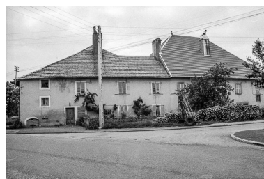
Ferme datée de 1797 : vue d'ensemble. Phot. Gilbert Poinot IVR43_19752500748Z
