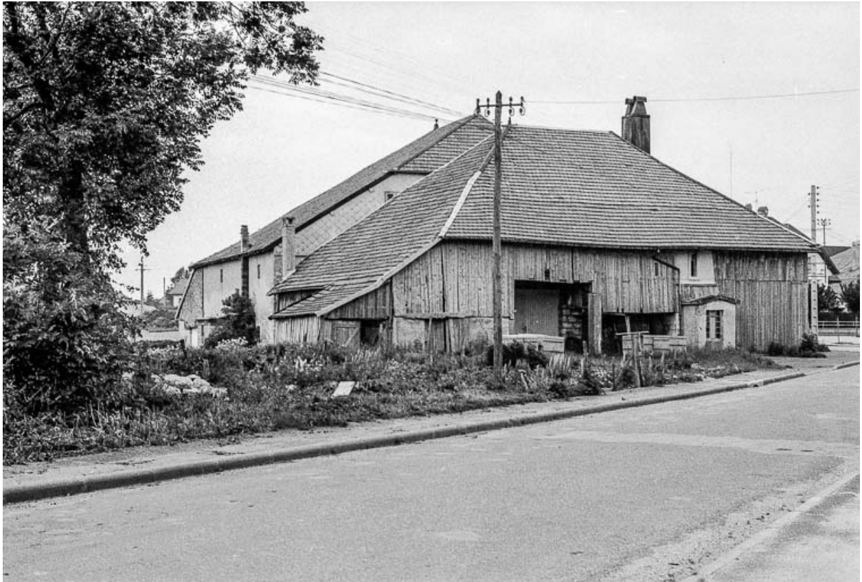
Ferme datée de 1797 : façade sur rue.
