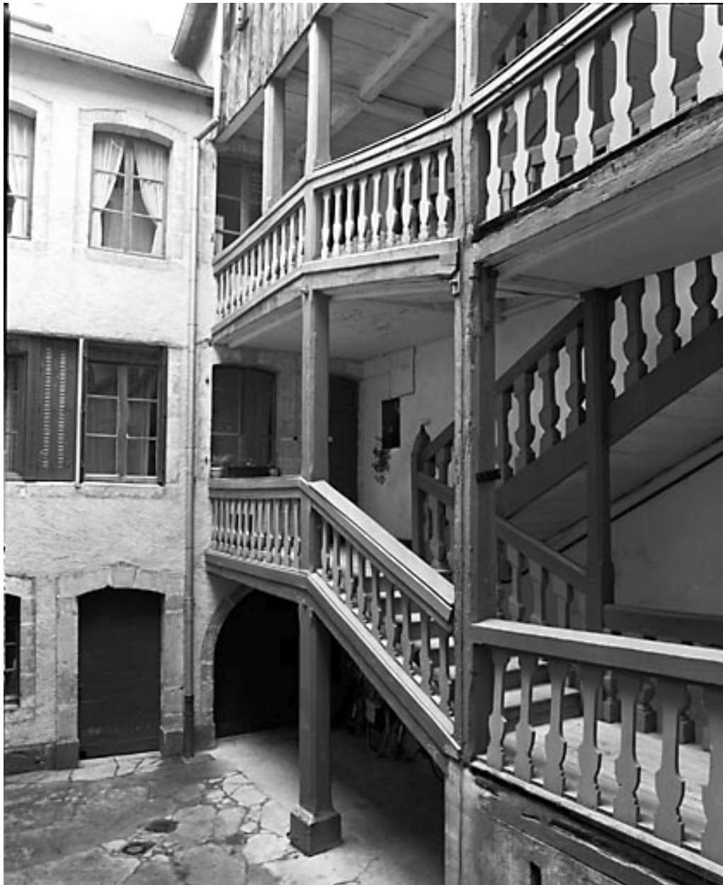
Escalier sur cour intérieure.
