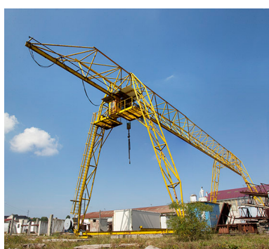
Portique roulant. Phot. Yves Sancey IVR43_20132501406NUC2A
