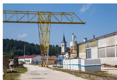
Ateliers vus en enfilade depuis l'est. Phot. Yves Sancey IVR43_20132501404NUC2A
