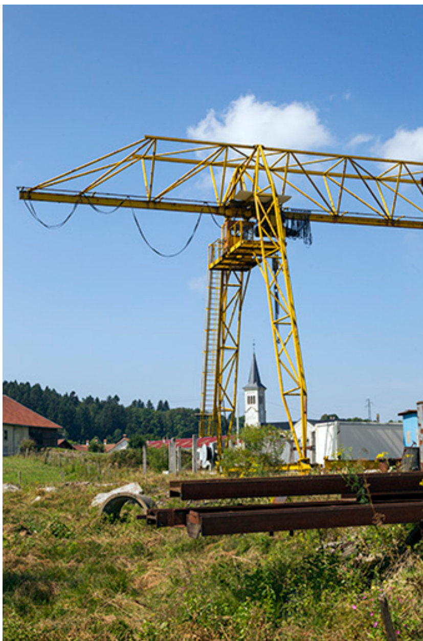
Portique roulant (extrémité sud).
