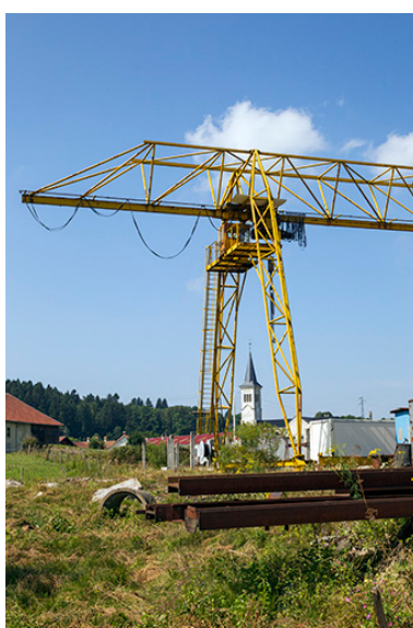
Portique roulant (extrémité sud). Phot. Yves Sancey IVR43_20132501405NUC2A
