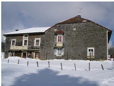
Façade postérieure. Phot. Marie-Pierre Reynet IVR43_20083900526NUC1A
